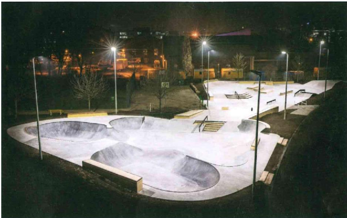
Bild 10: Beispiel LED-Beleuchtung einer Skateanlage
