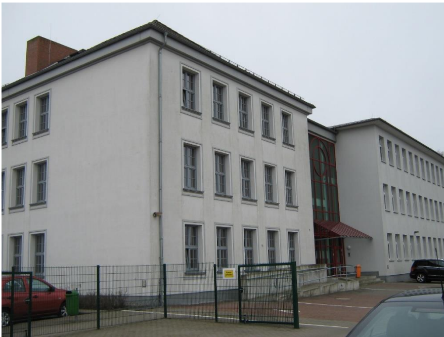
Bild 4: Nordost-Fassade der Berufsschule
