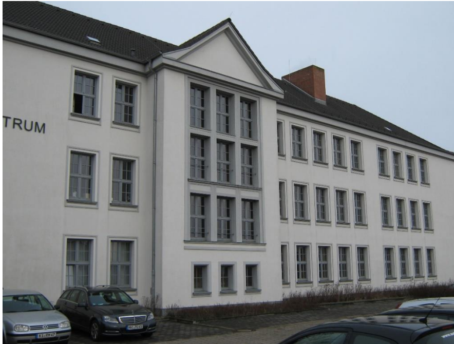
Bild 1: Südost-Fassade der Berufsschule
