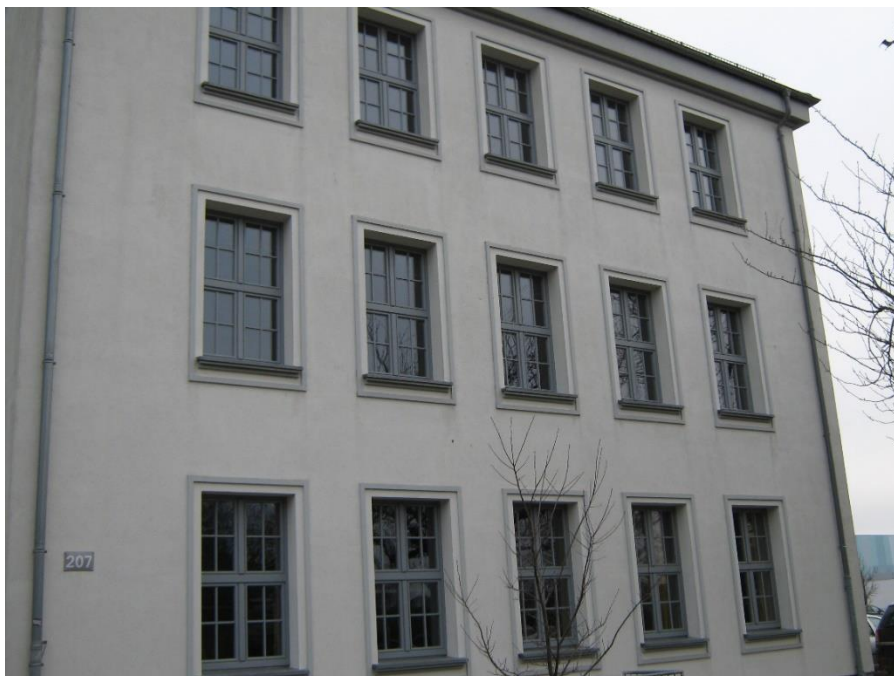
Bild 2: Südwest-Fassade der Berufsschule
