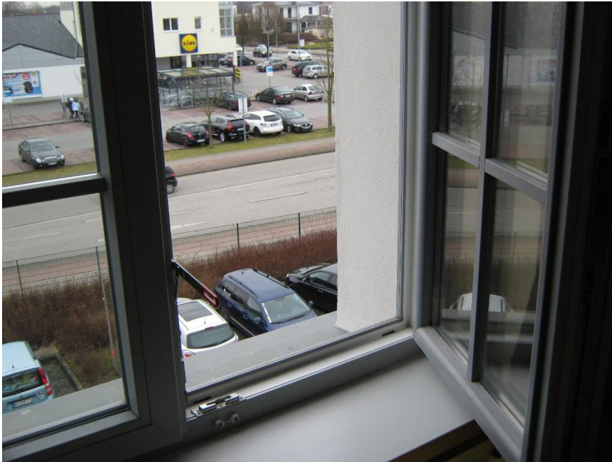
Bild 7: Geöffneter Drehkipp-Flügel im Raum 312, unterhalb des Kämpfers, Südost-Fassade
