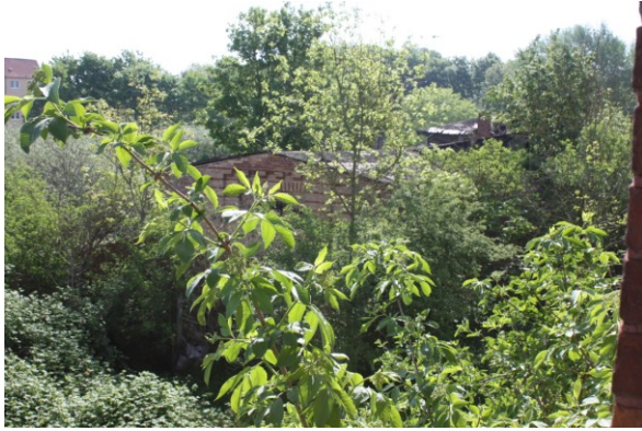
Ruine des Wirtschaftsgebäude in der Brachfläche
