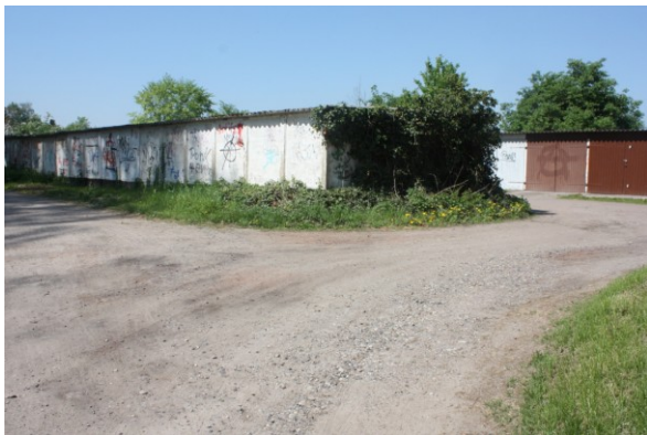
Garagenkomplex an der südwestlichen Grenze des Plangebietes
