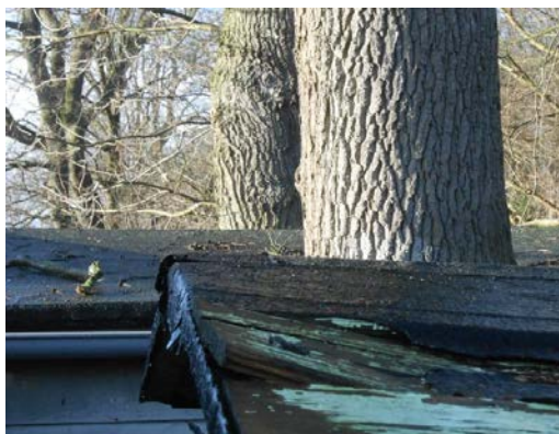
Abb. 22: Stieleiche (Baum-Nr. 9) Eingebauter Stamm (Quelle: Gutachten FRANIEL)
