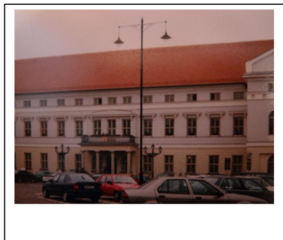
...nach der Erschließungsmaßnahme
