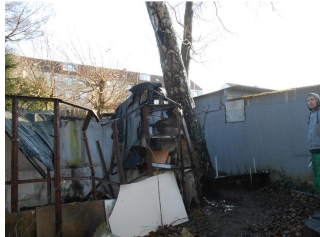
Abb.20: unterer Stammbereich und Stammanlauf
