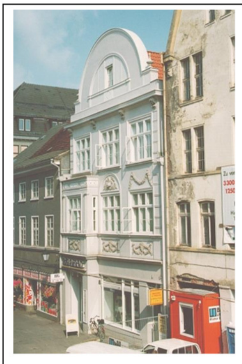
Straßenansicht nach der Sanierungsmaßnahme
