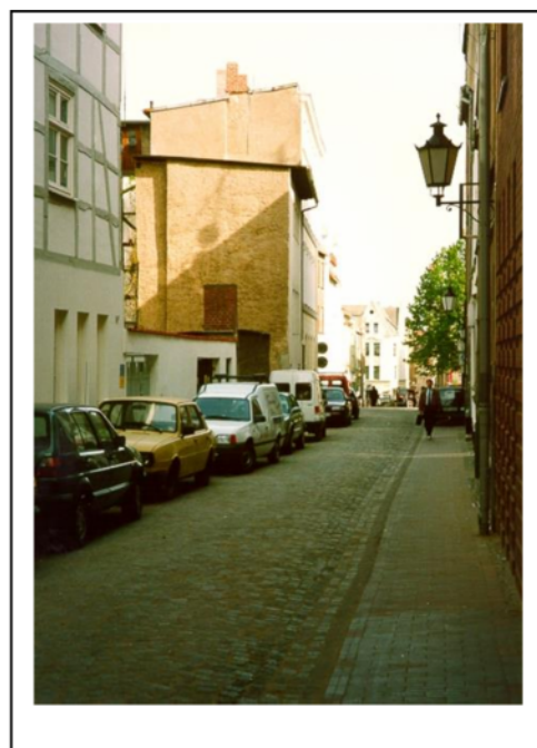
... nach der Erschließungsmaßnahme
