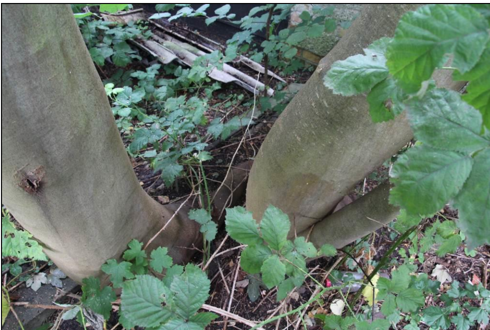
Abbildung 13: Verlauf der Wurzeln entlang von Betonelementen (Baum Nr. 21)
