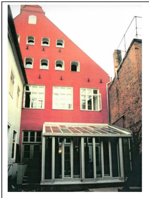
Hofbereich nach der Sanierungsmaßnahme
