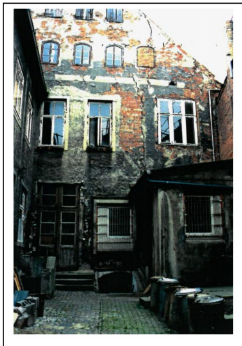
Hofbereich vor der Sanierungsmaßnahme
