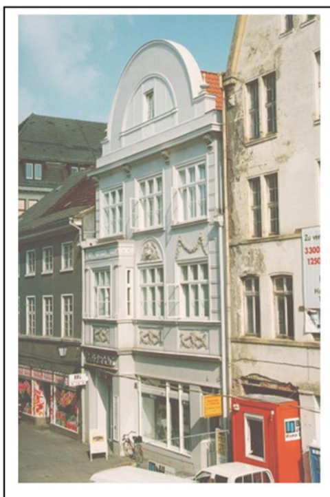
Straßenansicht nach der Sanierungsmaßnahme
