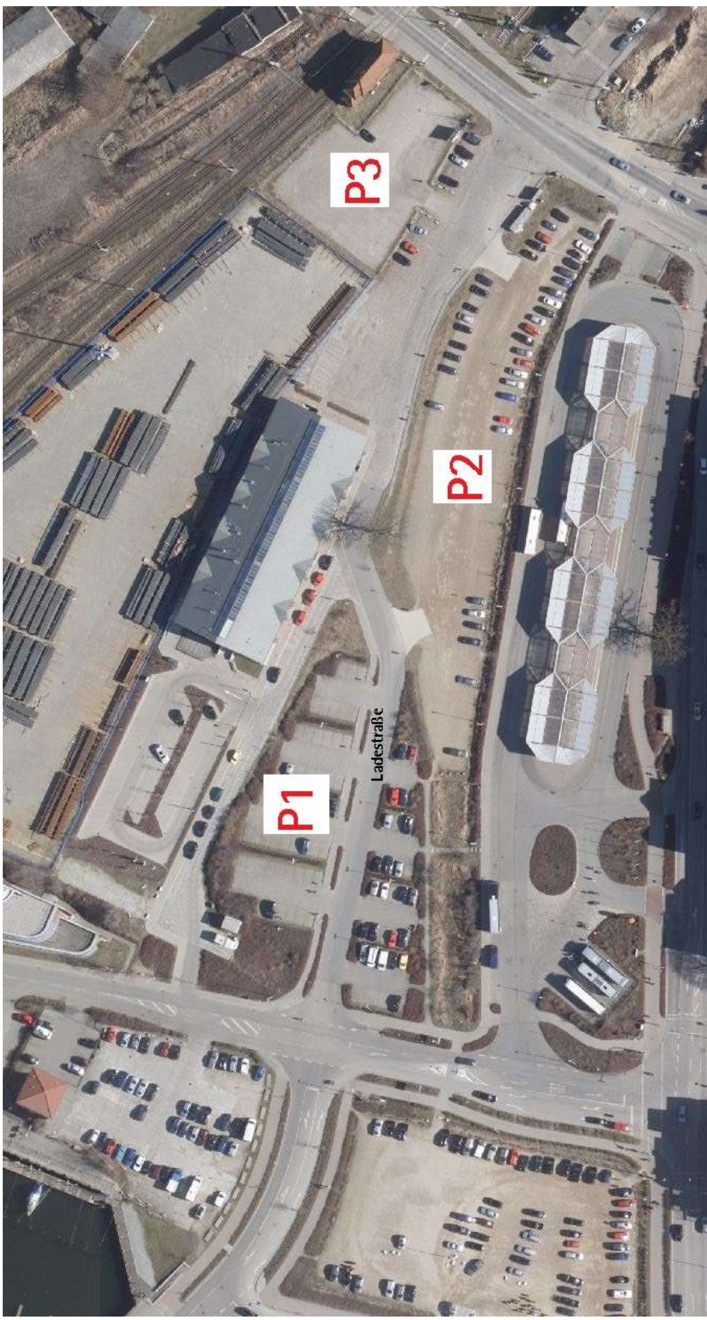
Anlage PP Altstadt/Bahnhof/ZOB
