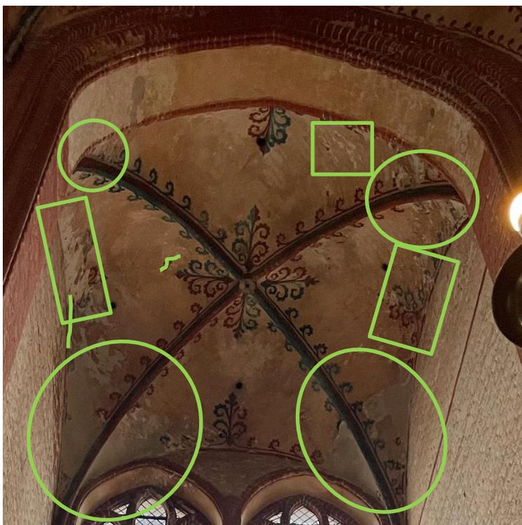
**Bild 11:** zu Punkt 2.4: Gewölbe NK3 mit markiertem Rissbild, Versalzungen, Putz- und Fassungsverlust.
