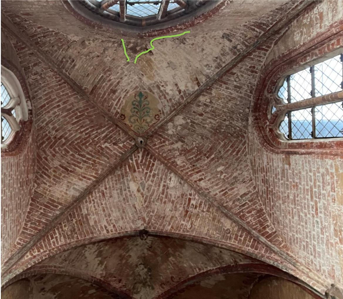
**Bild 14:** zu Punkt 2.5: Gewölbe über SAK1 mit markiertem Rissbild, vermutlich gelockerten Ziegeln, Versalzungen, nahezu komplettem Putz- und Fassungsverlust.
