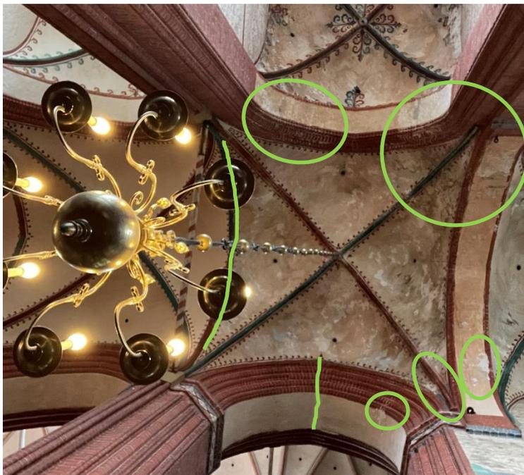
**Bild 10:** zu Punkt 2.3: Gewölbe NS3 und Laibungsbögen mit markiertem Rissbild, Versalzungen, Putz- und Fassungsverlust.
