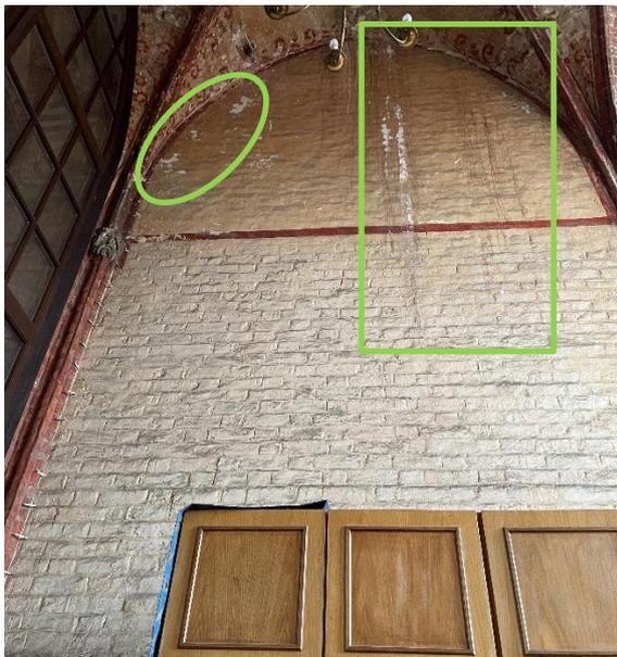
**Bild 19:** zu Punkt 2.6: Fassung Westwand ist erheblich staubverschmutzt, weiße und dunkle Verlaufspuren im oberen Drittel.
