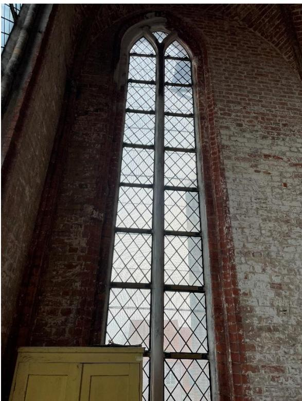
**Bild 17:** zu Punkt 2.5: Fassung Ostwand, großflächig komplett verloren gegangen. Fassungsreste stark verschmutzt.
