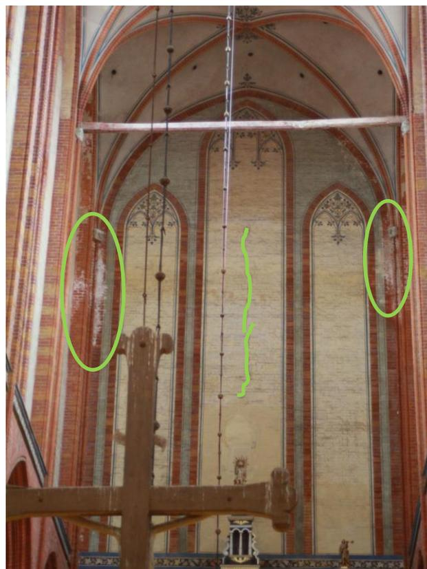
**Bild 06:** zu Punkt 2.1: Westwand mit markiertem Riss
