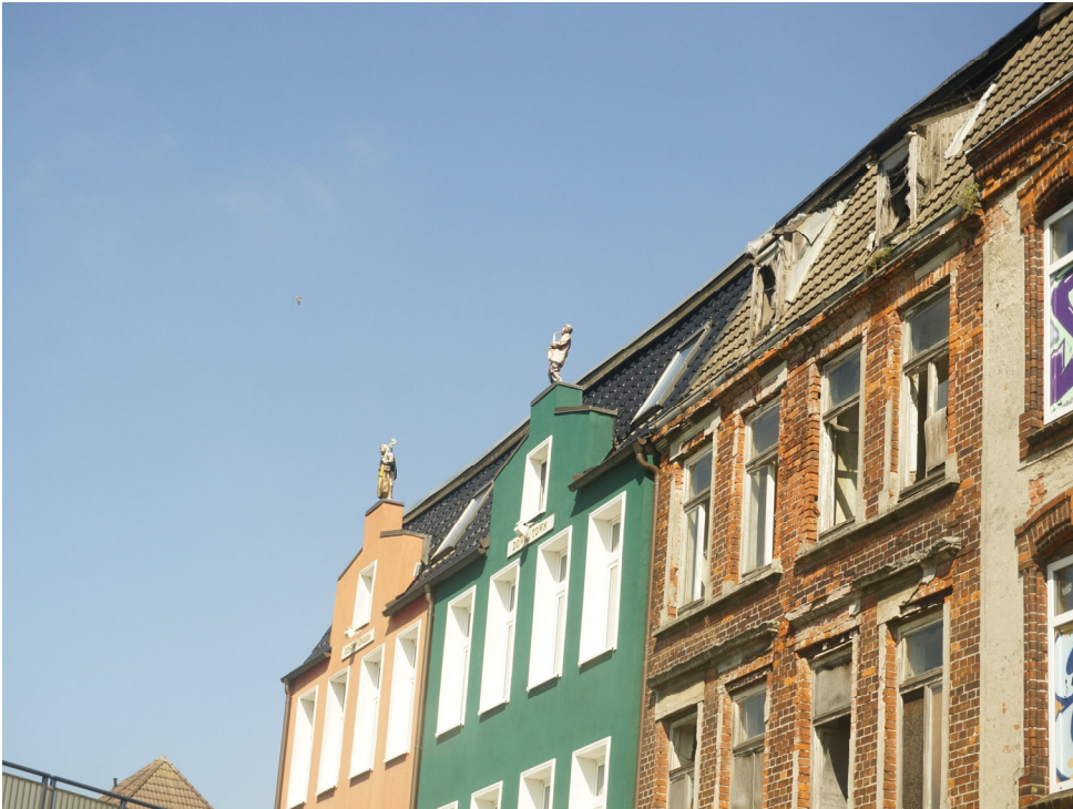
Gebäude 8 (orange), Gebäude 9 (grün), Gebäude 10 und 11 (Backsteinmauerwerk)
