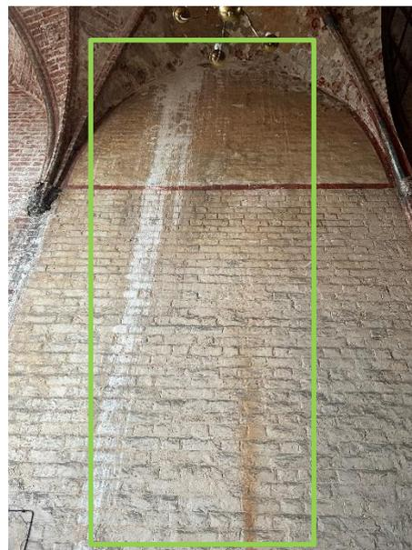
**Bild 20:** zu Punkt 2.6: Fassung Ostwand ist erheblich staubverschmutzt, weiße und braune Verlaufspuren raumhoch.
