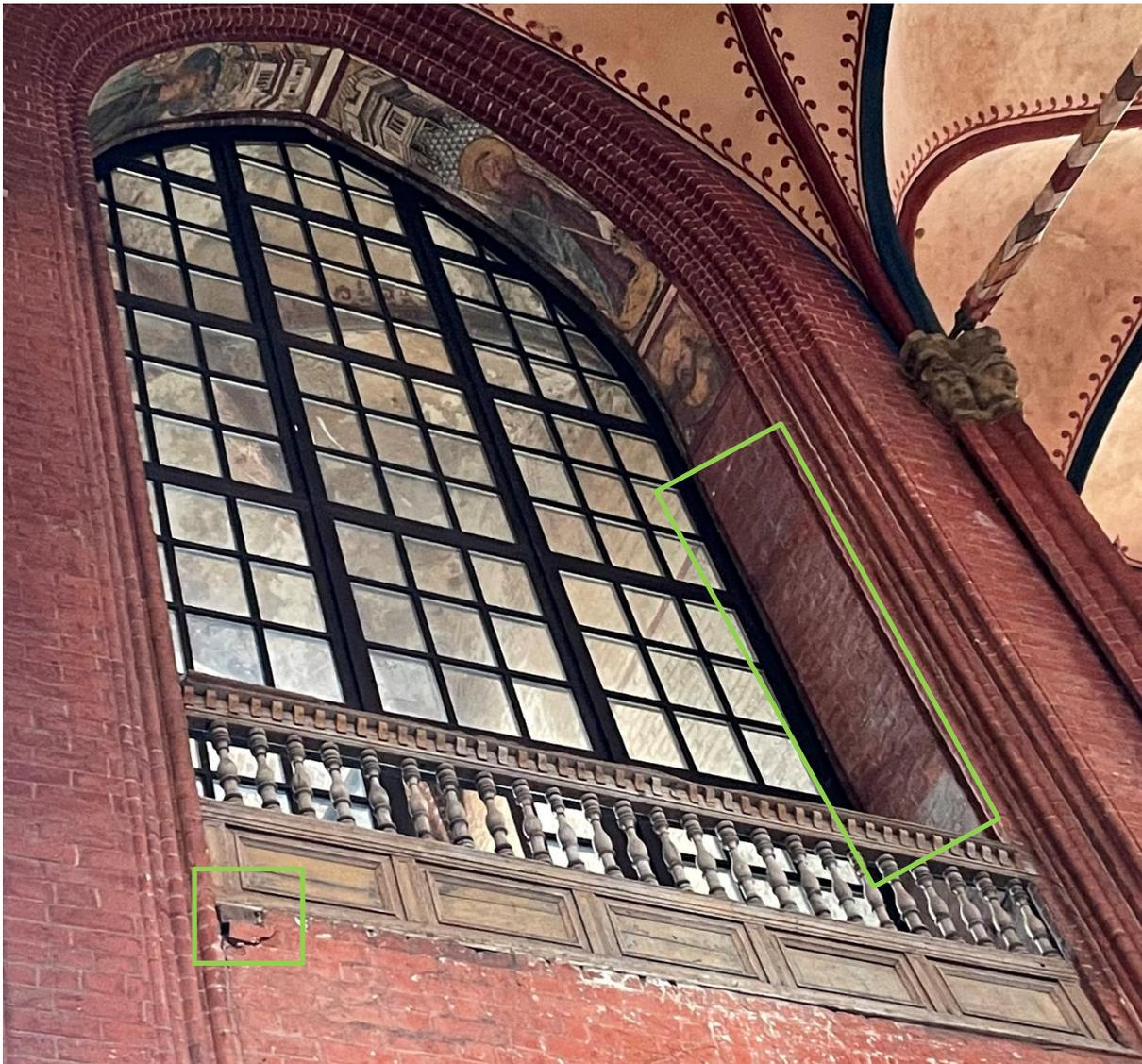
**Bild 21:** zu Punkt 2.6: Raumhohes Sprossenfenster als Südöffnung von SAK2 zu schmaler Empore mit Balustrade. Die mauerwerkssichtige Bogenlaibung ist staubverschmutzt. Reinigung/leichtes Anschleifen und Holzbehandlung der historischen Balustrade empfehlenswert. Unterhalb ist ein Ziegel zu sichern!
