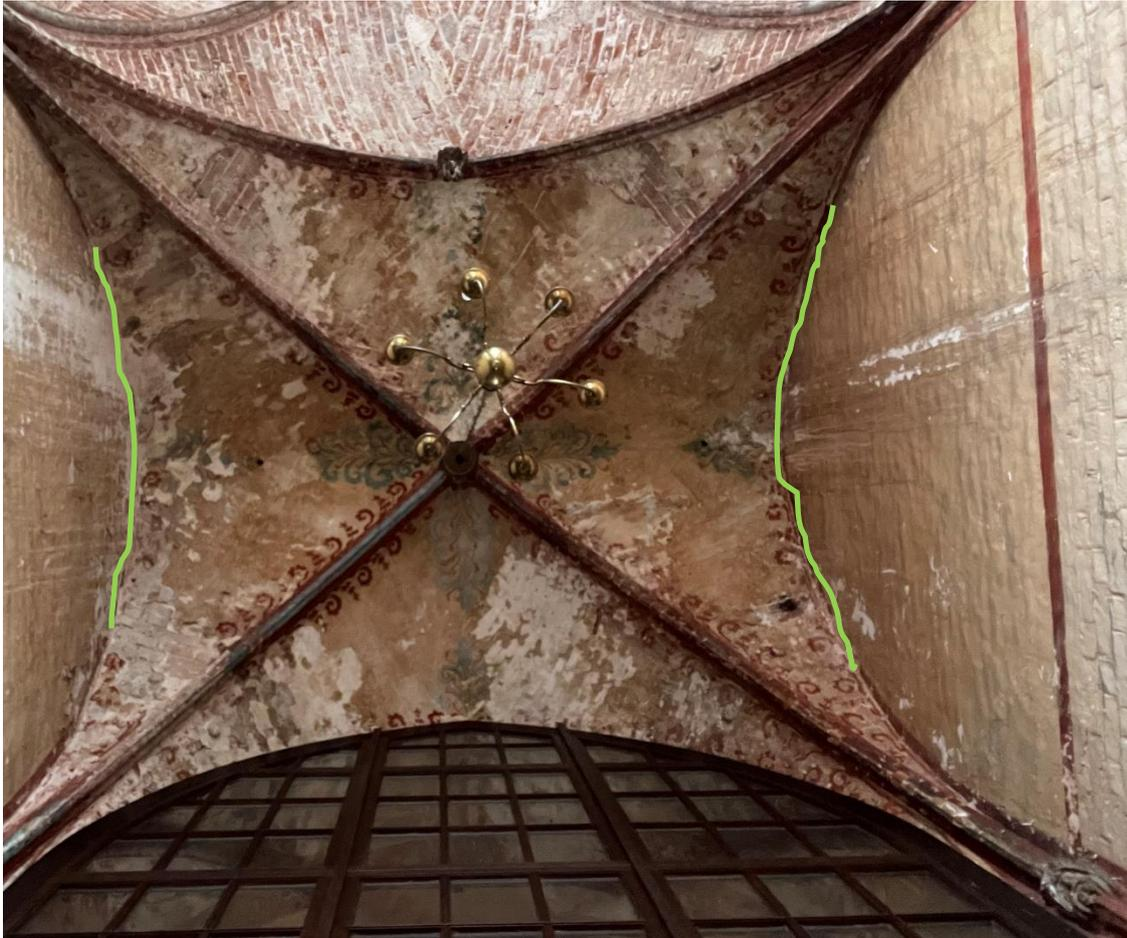
**Bild 18:** zu Punkt 2.6: Gewölbe über SAK2 mit markierten Gewölbe-Abrissen, großflächigen Versalzungs- und abgängigen Putzbereichen und einer kompletten Schädigung der Malschicht.
