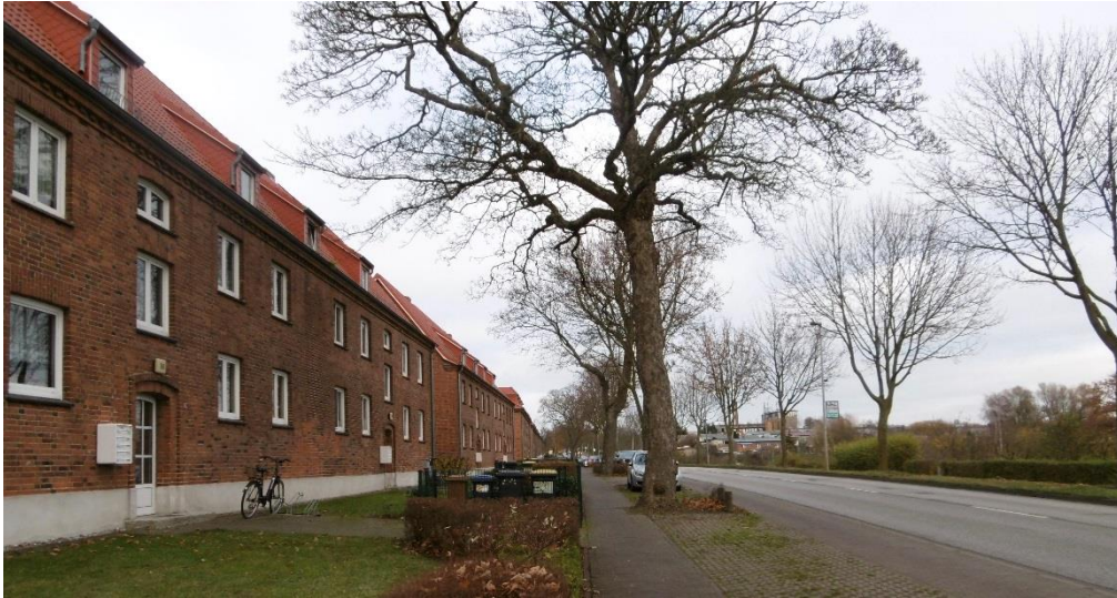
Abbildung 23: Lärmbetroffene Gebäude Poeler Straße
