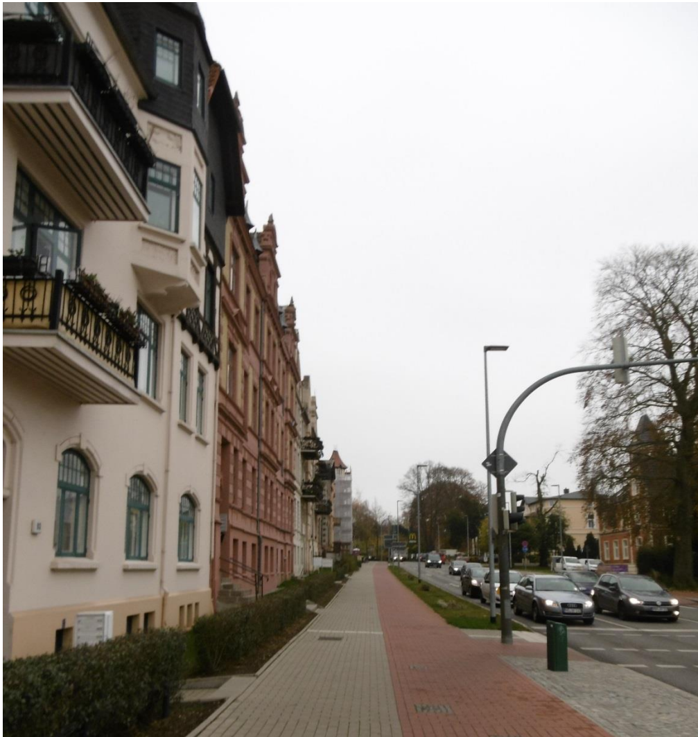
Abbildung 4: Lärmbetroffene Gebäude Dr.-Leber-Straße
