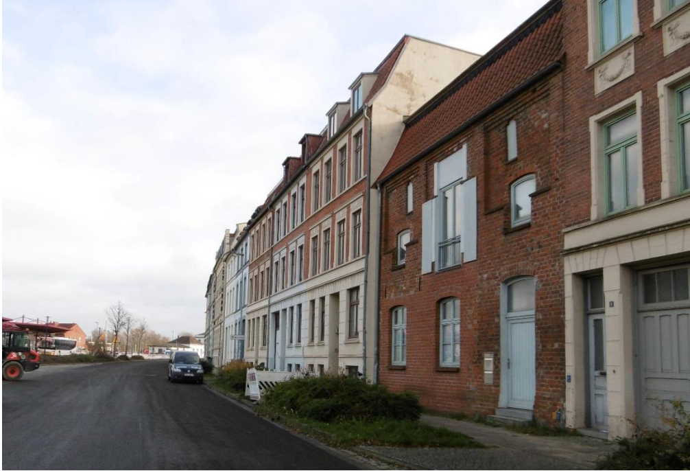
Abbildung 7: Lärmbetroffene Gebäude Wasserstraße
