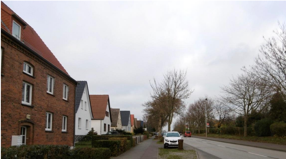
Abbildung 22: Lärmbetroffene Gebäude Poeler Straße
