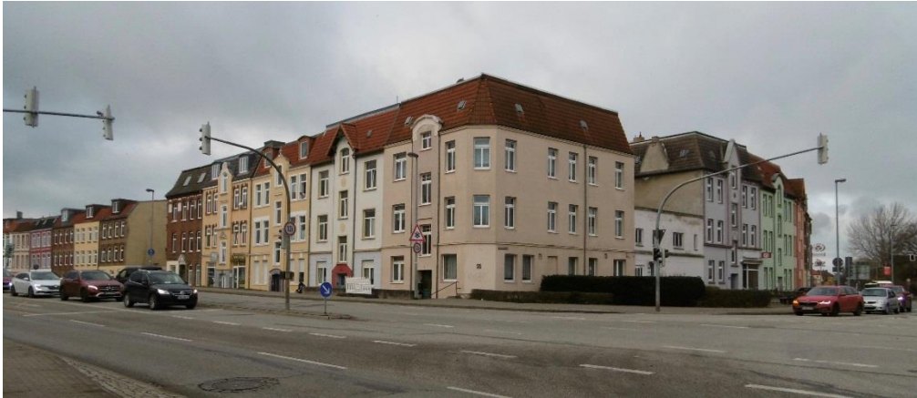
Abbildung 12: Lärmbetroffene Gebäude L12 Hochbrücke
