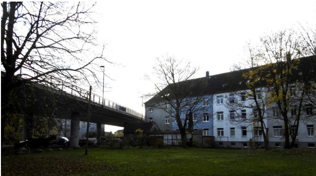
Abbildung 13: Lärmbetroffene Gebäude L12 Hochbrücke
