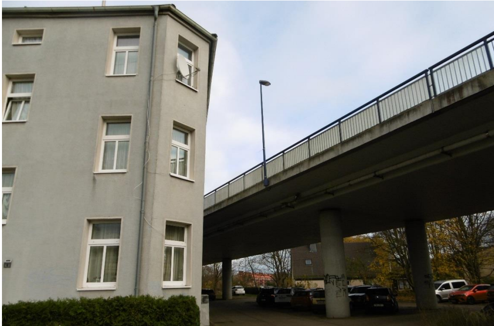
Abbildung 14: Lärmbetroffenes Gebäude L12 Hochbrücke
