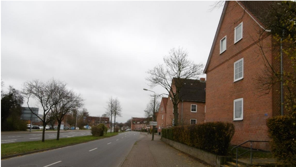
Abbildung 10: Lärmbetroffene Gebäude Bürgermeister-Haupt-Straße
