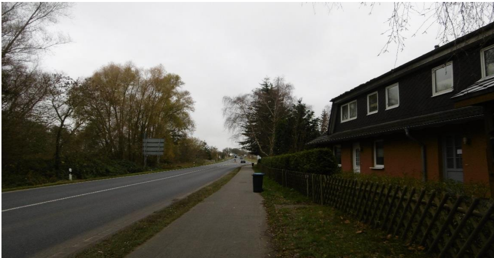
Abbildung 9: Lärmbetroffenes Gebäude B208
