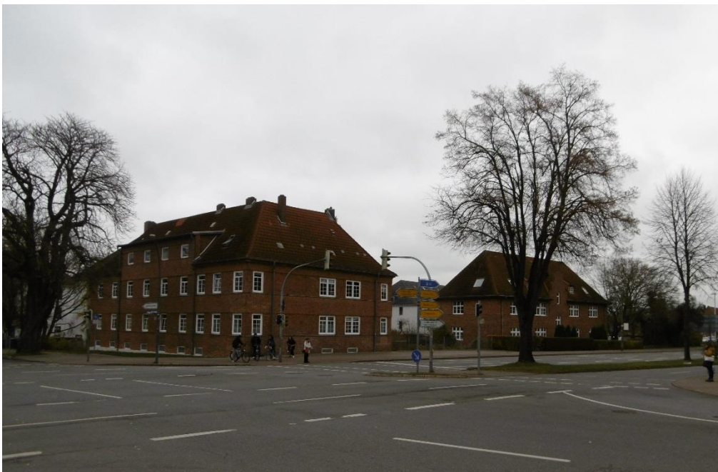
Abbildung 11: Lärmbetroffene Gebäude Bürgermeister-Haupt-Straße
