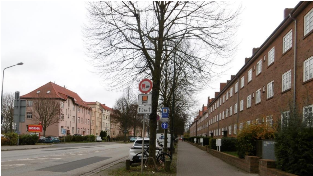
Abbildung 24: Lärmbetroffene Gebäude Rostocker Straße
