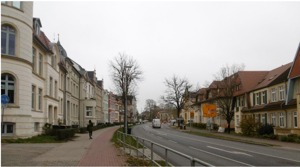
Abbildung 3: Lärmbetroffene Gebäude Dahlmannstraße
