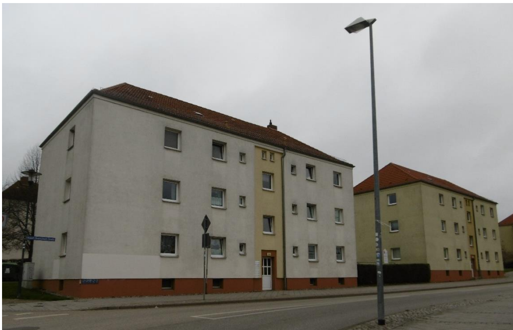
Abbildung 25: Lärmbetroffene Gebäude Rudolph-Breitscheid-Straße
