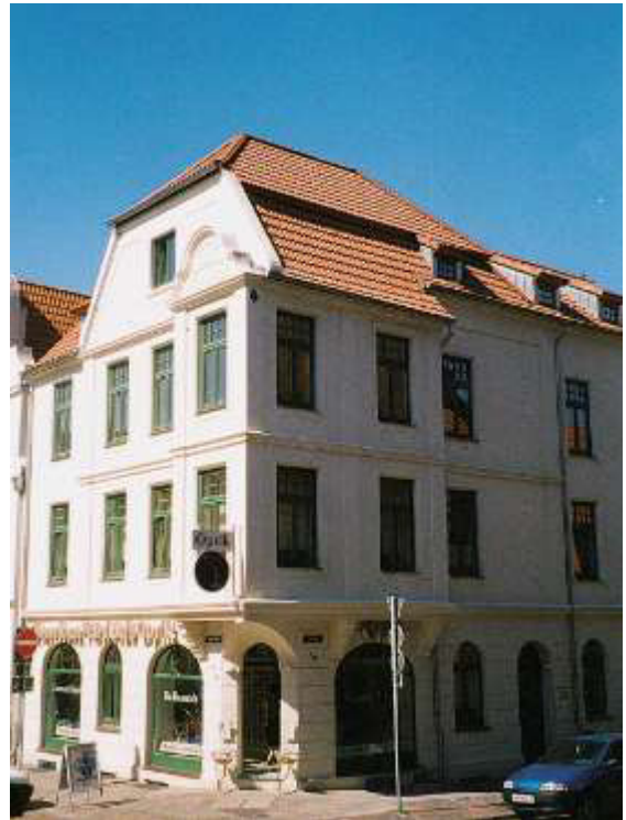
... nach der Sanierung
