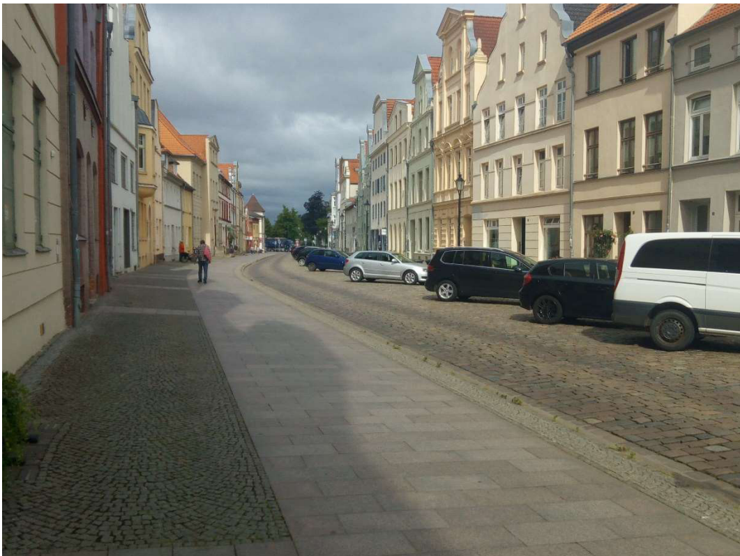
... nach der Sanierung
