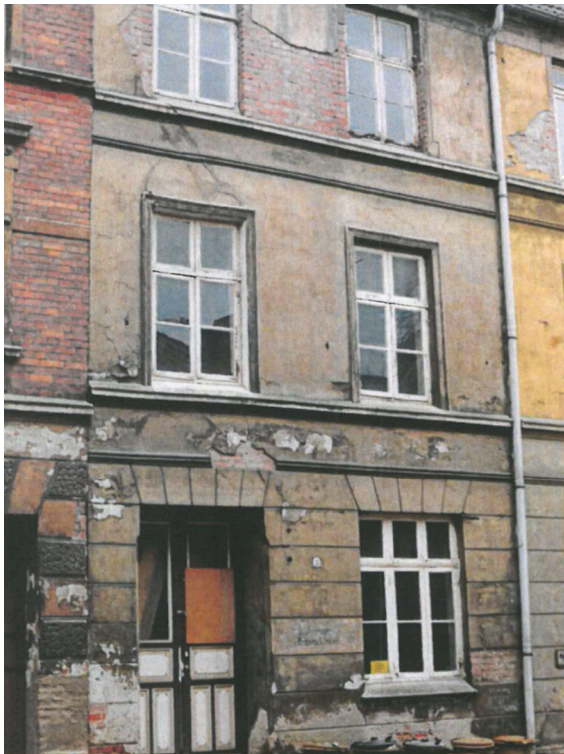
... vor der Sanierung
