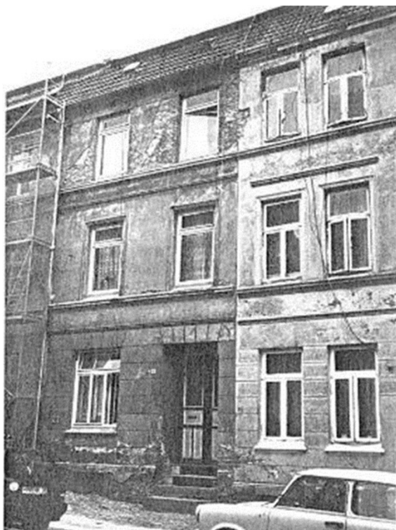
... vor der Sanierung
