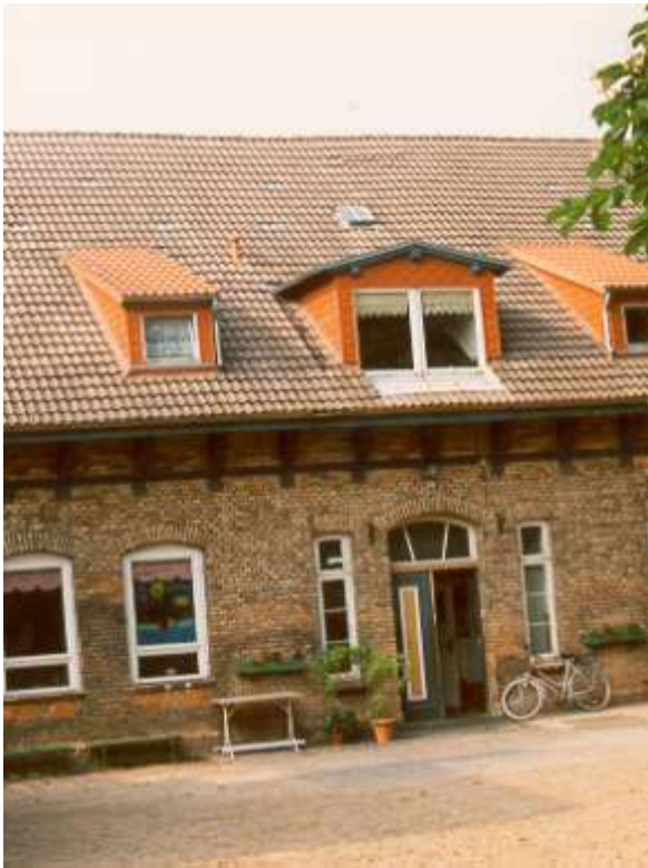
... vor der Sanierung
