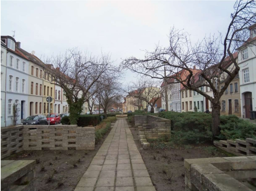
Mittlerer Abschnitt vor der Sanierung
