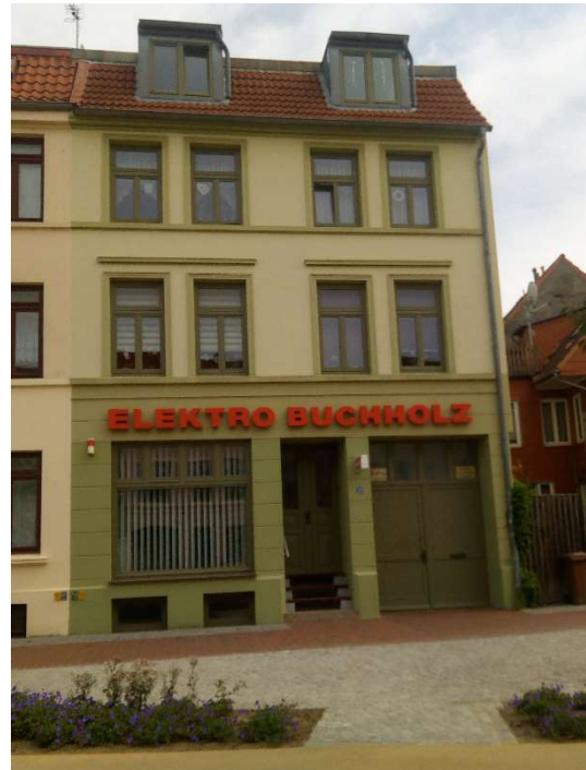
... nach der Sanierung
