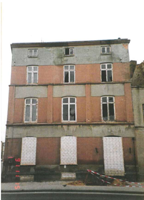
Nr. 61 vor der Sanierung
