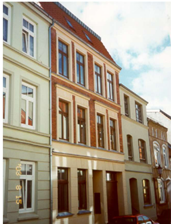
... nach der Sanierung
