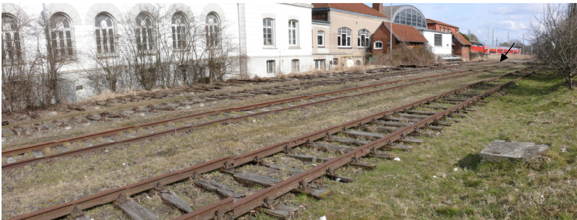
Abbildung 10: Blick auf das nordwestliche Plangebiet südlich des Bahnhofgebäudes, der Pfeil markiert den Übergang zwischen Vorempfangsgebäude und Bahnhofgebäude. Foto: Stadt Land Fluss 8.04.2013.
