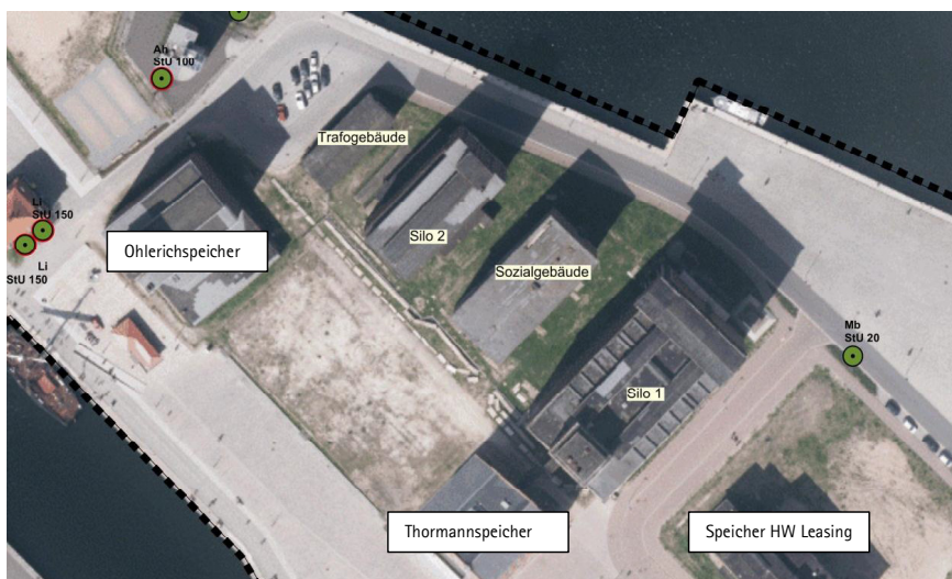
Abbildung 1 Überblick über die in den Jahren 2011 und 2014 untersuchten Gebäude
