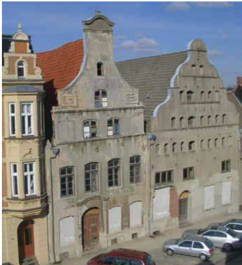
Spiegelberg 45/47 vor der Sanierung
