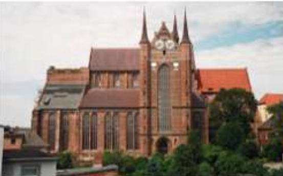
St.-Georgen-Kirche: Freiflächengestaltung westlich und Fortführung der Sanierung
