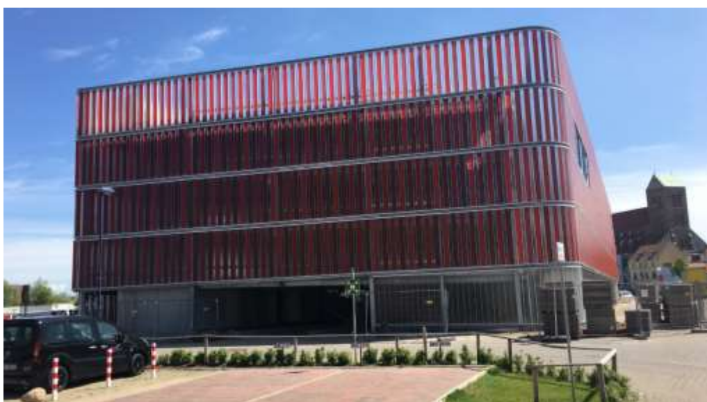
Parkhaus im Alten Hafen
