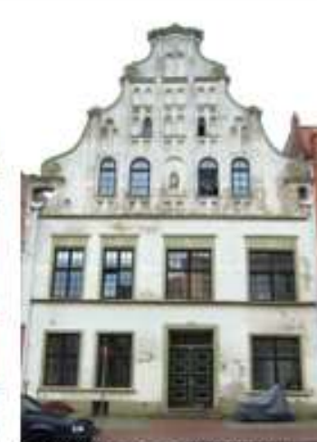
Bohrstraße 13 nicht realisiert
