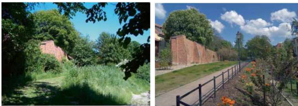
Stadtmauer vor und nach der Umgestaltung
