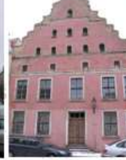
Sanierung Bohrstraße 15 (in Durchführung)
