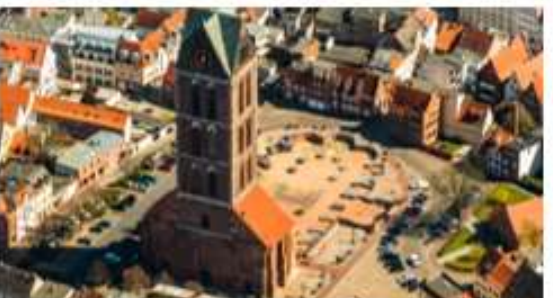
Stadttraum St.-Marien-Kirche; Erneuerung St. Marien-Kirchhof (5. BA); Schaffung Ausstellungsflächen über den Grundmauern von Alter Schule und Stadtmusikantenhaus
