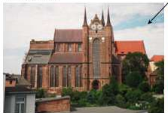
St.-Georgen-Kirche - Turm mit Aussichtsplattform und Aufzug ist realisiert, FFG westl. nicht realisiert
