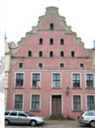
Sanierung Bohrstraße 15 (in Durchführung)
