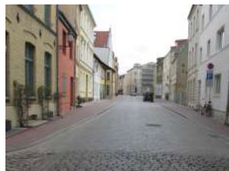
nach der Fertigstellung
