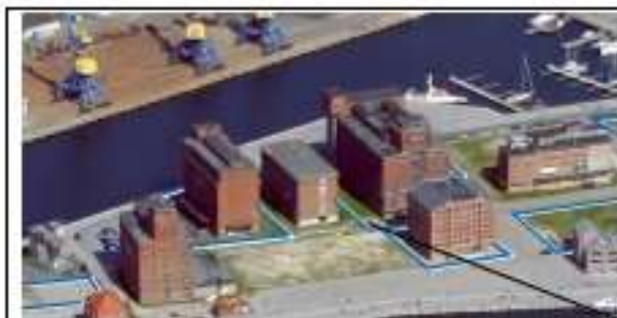
Sanierung und Umnutzung der Speicher im Alten Hafen (Ohlerich-Speicher realisiert, Kruse-Speicher in Durchführung)
