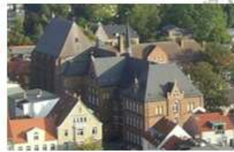
Sanierung IGS einschließlich Hofgestaltung (in Durchführung)
