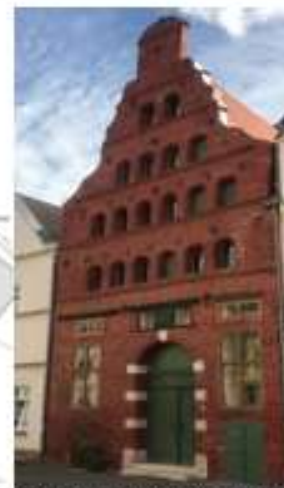
Sanierung Spiegelberg 48a (realisiert)
