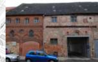
Sanierung Papestraße 2a
