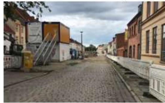
Um- und Ausbau Claus-Jesup-Straße sowie Umgestaltung des Grünstreifens (in Durchführung)
