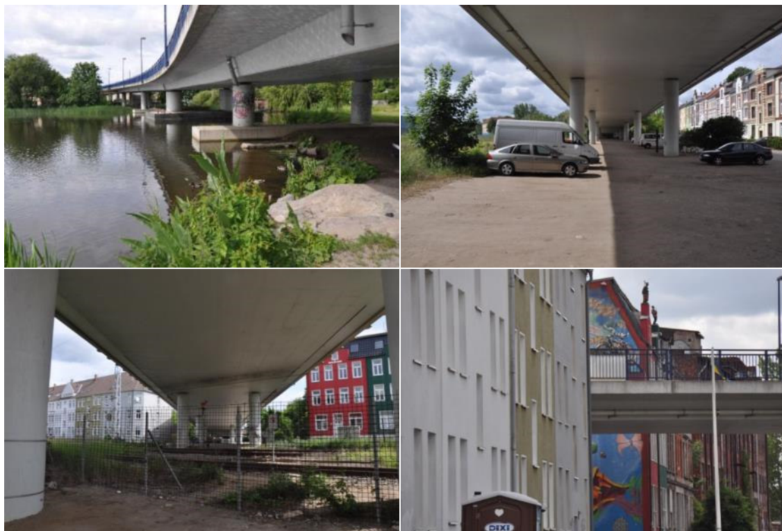
Bild 3: Städtebauliches Umfeld im Bereich der Brücke (© IB Klaeser 2012)
