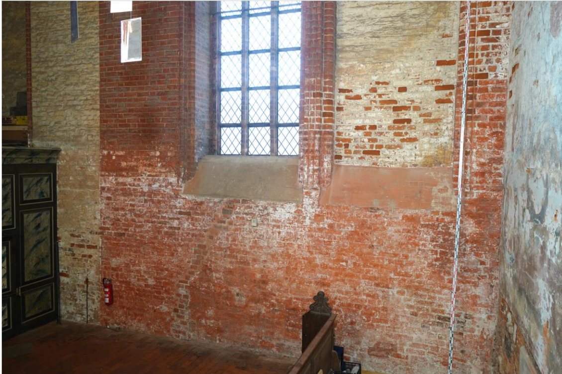
Westwand und Anschluss an die Südwand mit Wandbild „Wurzel Jesse“, Windfang des ehemal. Haupteinganges
