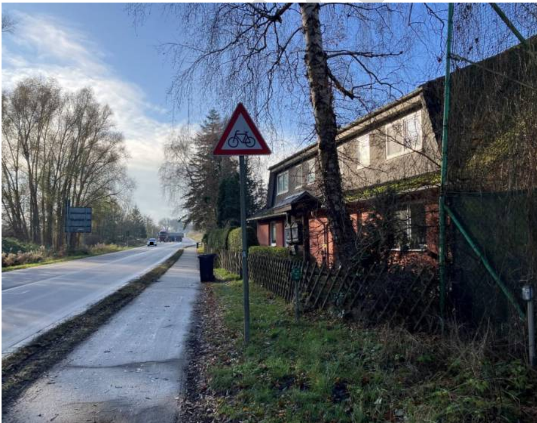
Abbildung 9: Lärmbetroffenes Gebäude B 208
