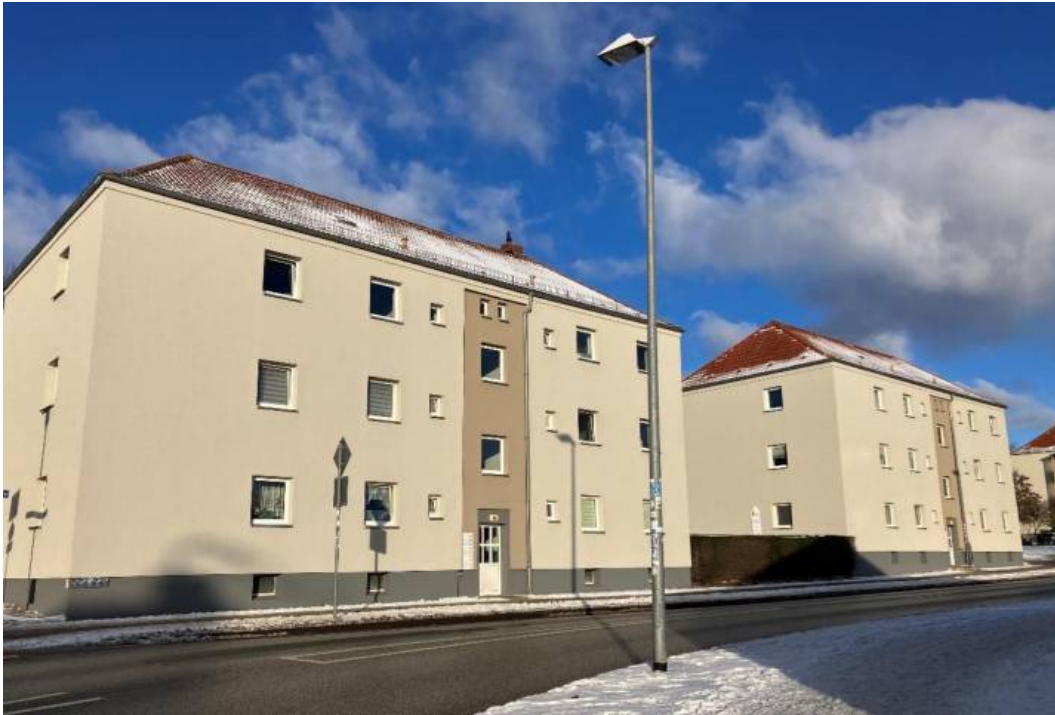
Abbildung 21: Lärmbetroffene Gebäude Rudolph-Breitscheid-Straße
