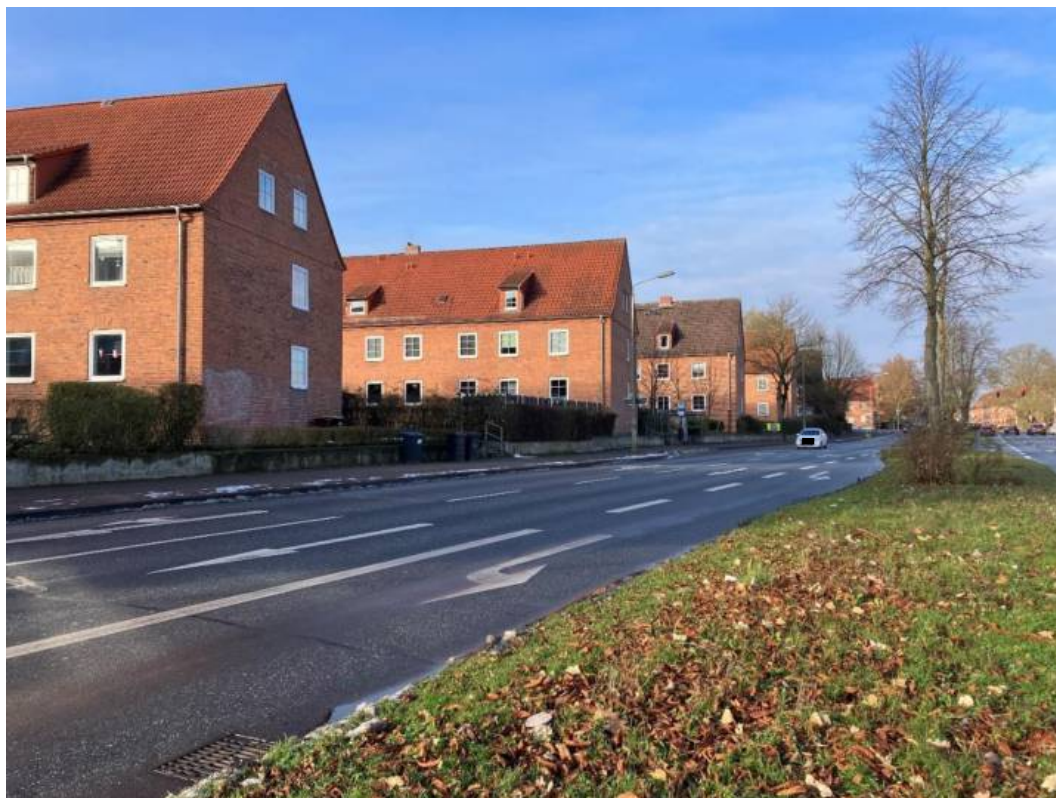
Abbildung 10: Lärmbetroffene Gebäude Bürgermeister-Haupt-Straße
