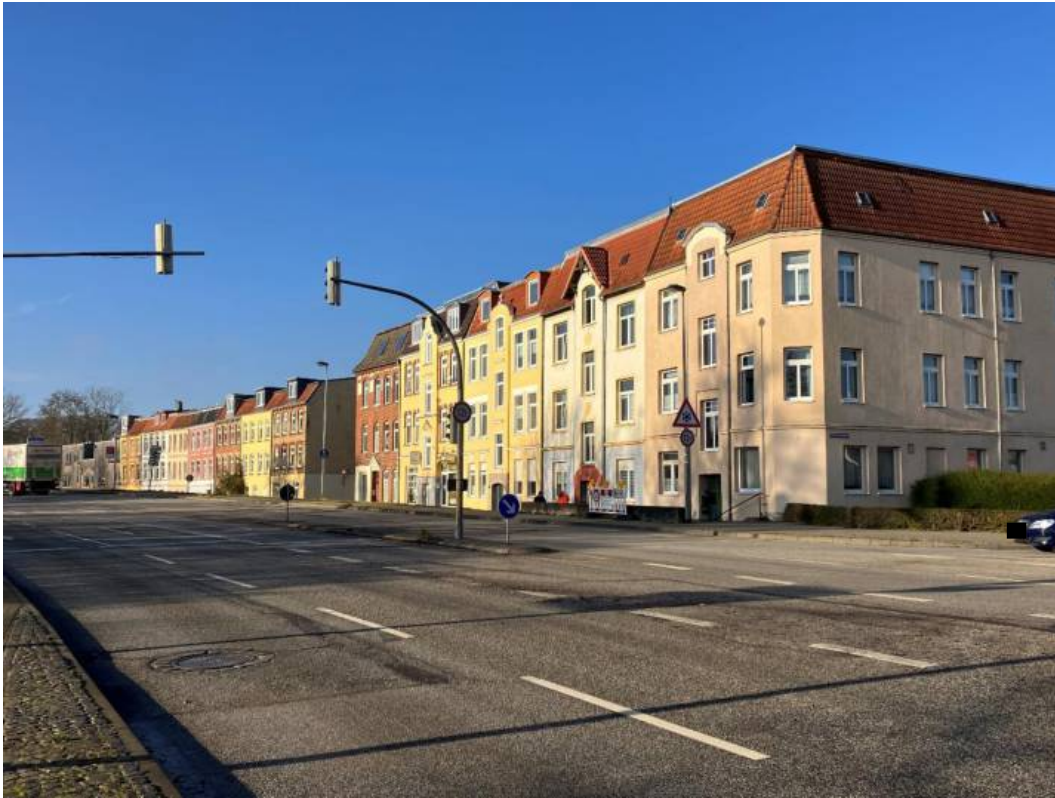
Abbildung 19: Lärmbetroffene Gebäude Rostocker Straße
