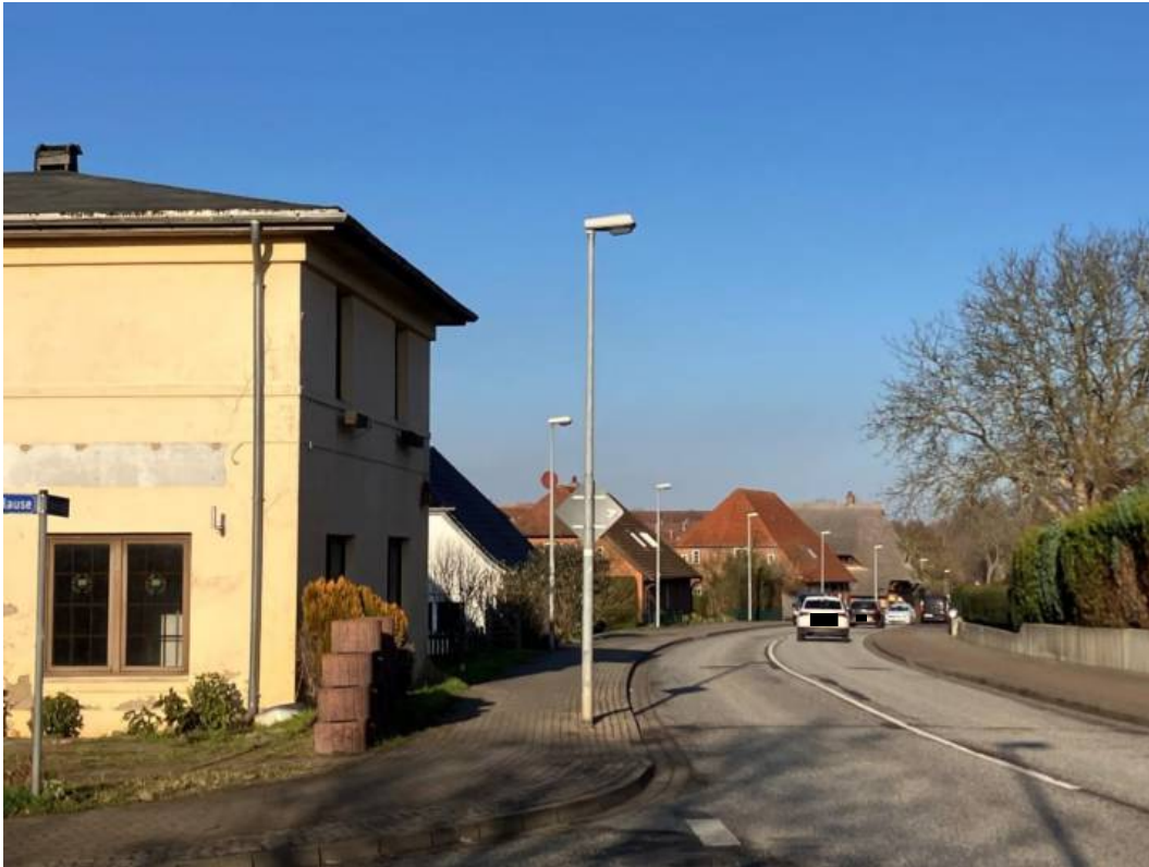
Abbildung 12: Lärmbetroffene Gebäude Inselstraße
