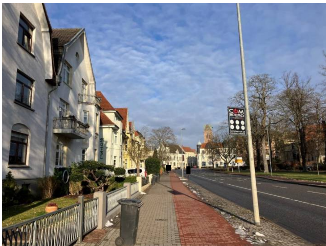
Abbildung 22: Lärmbetroffene Gebäude Schweriner Straße
