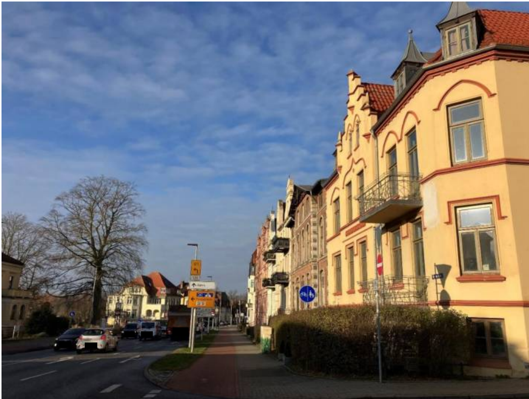
Abbildung 5: Lärmbetroffene Gebäude Dr.-Leber-Straße
