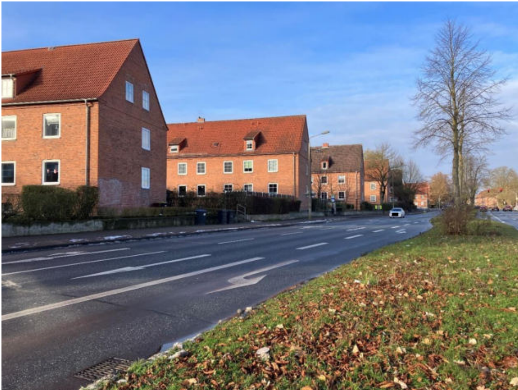
Abbildung 10: Lärmbetroffene Gebäude Bürgermeister-Haupt-Straße
