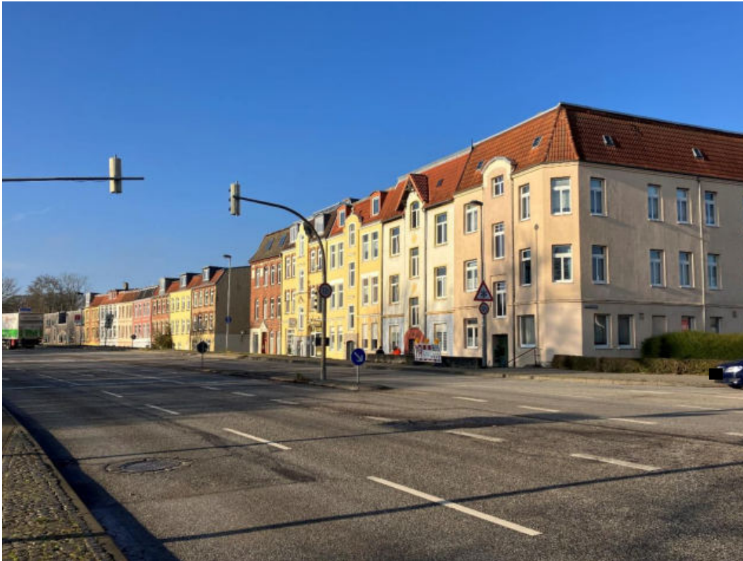
Abbildung 19: Lärmbetroffene Gebäude Rostocker Straße
