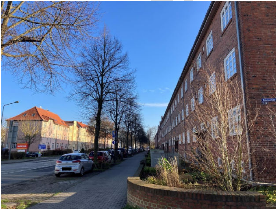
Abbildung 20: Lärmbetroffene Gebäude Rostocker Straße
