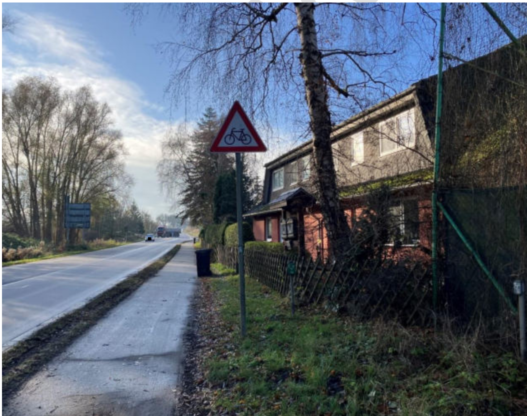
Abbildung 9: Lärmbetroffenes Gebäude B 208
