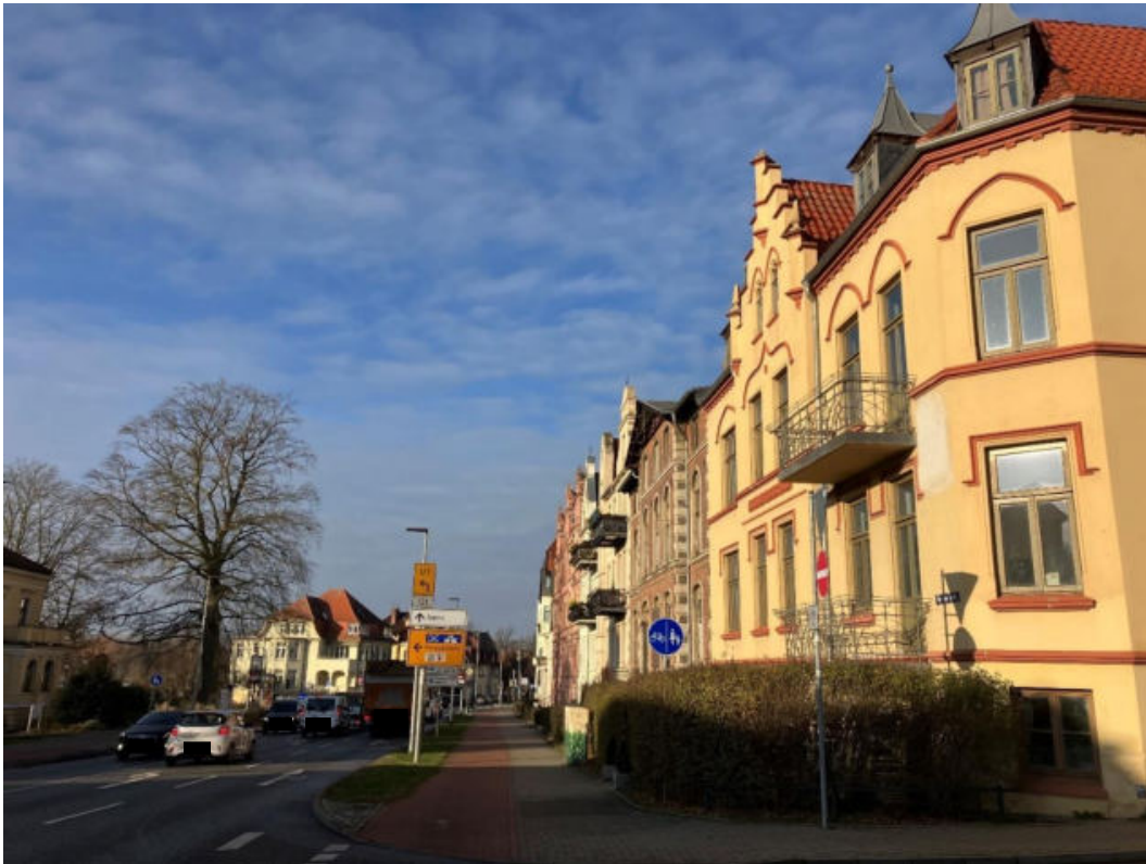
Abbildung 5: Lärmbetroffene Gebäude Dr.-Leber-Straße
