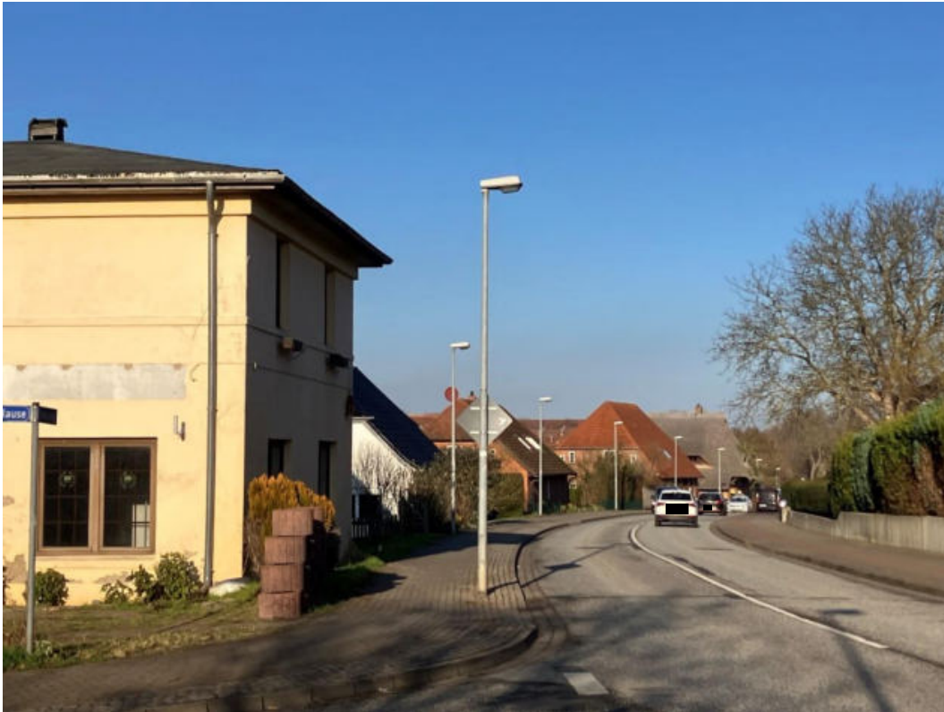
Abbildung 12: Lärmbetroffene Gebäude Inselstraße
