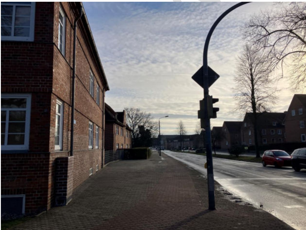
Abbildung 11: Lärmbetroffene Gebäude Bürgermeister-Haupt-Straße
