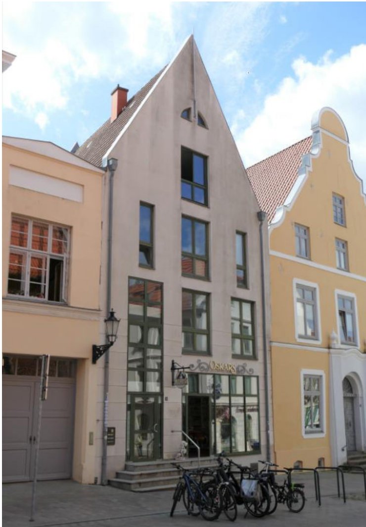
Abbildung 7: Fassade Neubau Lübsche Straße 46
