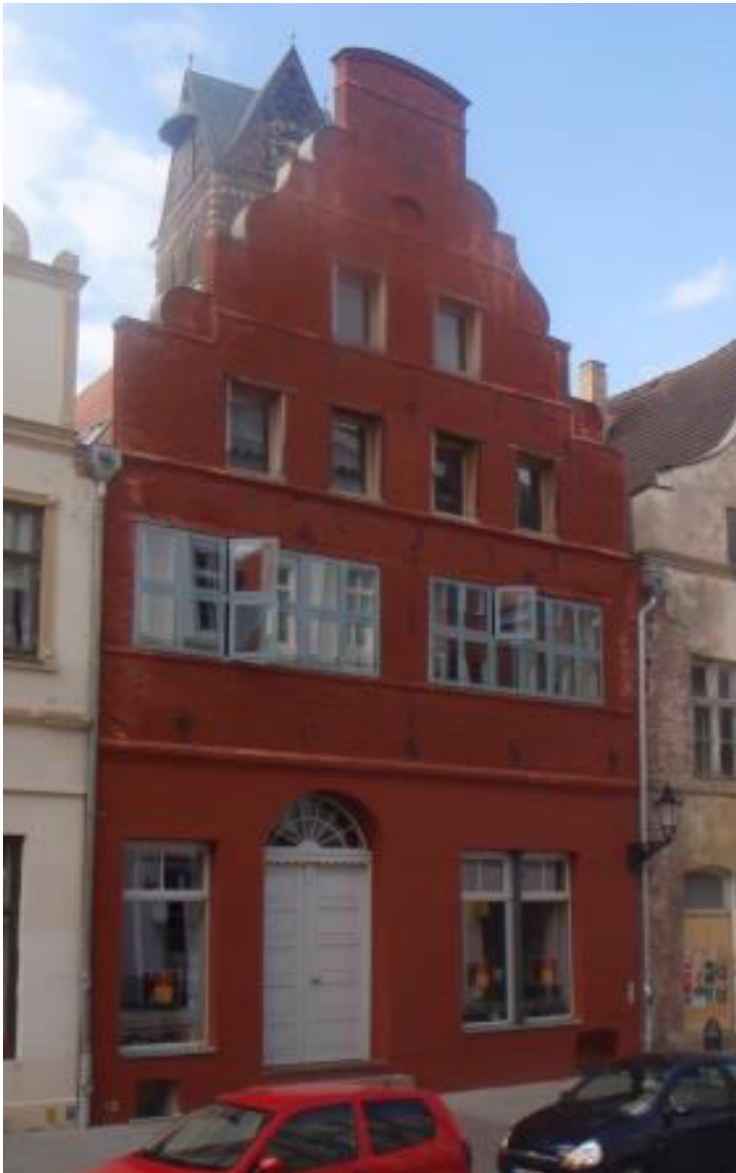
Abbildung 8: Fassade Lübsche Straße 14 nach Abschluss der Sanierung
