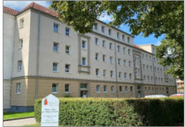
Beispiel Fassadensanierung – vorher (links) und nachher (rechts)
