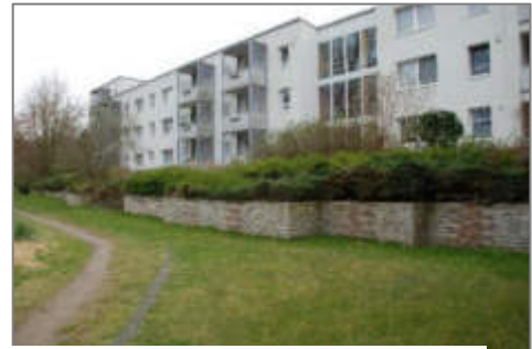
Lübsche Str. 158 vor Maßnahmen
