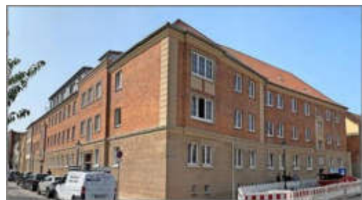
Claus-Jesup-Str./ Zeughausstr. nach der Fassadensanierung
