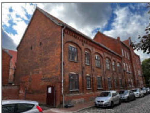
Neustadt 1-1b, erkennbare Feuchtigkeitsschäden
