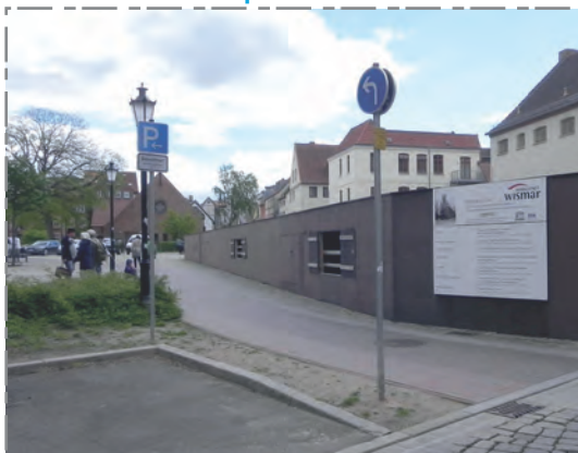
Blick auf bestehende Schutzeinhausung der Alten Schule
