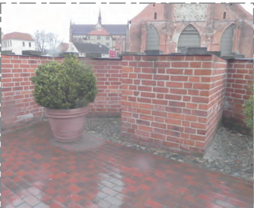
Blick auf Chorbereich aus der Sargmacherstraße
