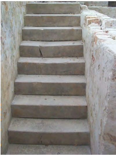
Detail Treppe im Kellergeschoss
