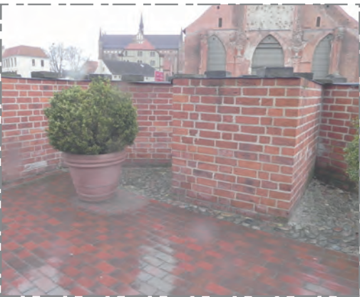
Blick auf Chorbereich aus der Sargmacherstraße
