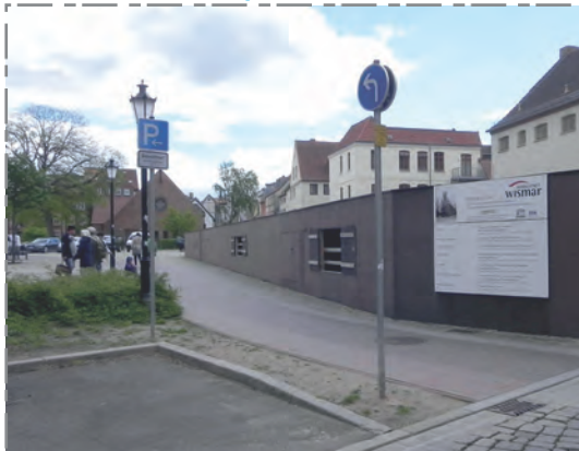
Blick auf bestehende Schutzeinhausung der Alten Schule
