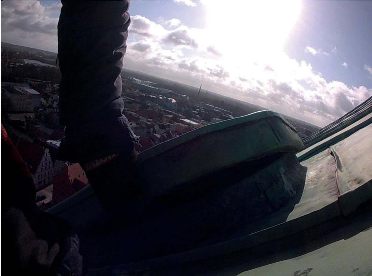
**Bild T-18:** Aufgebogene Falze, auch an der Dachluke. Verformter Stehfalz.
