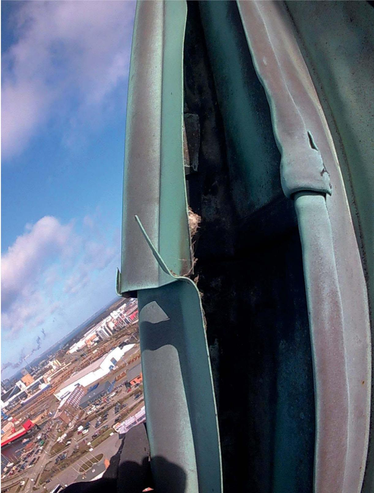
Bild T-15: Großflächig aufgebogene und lose Ortgangeindeckung.
