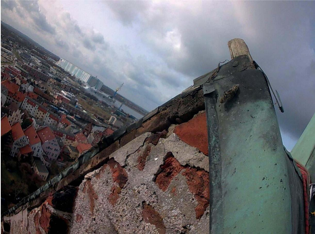
Bild T-07: Poröse Ziegel mit Abplatzungen und verwittertem Putz. Ortgangblech links wurde sichergestellt.
