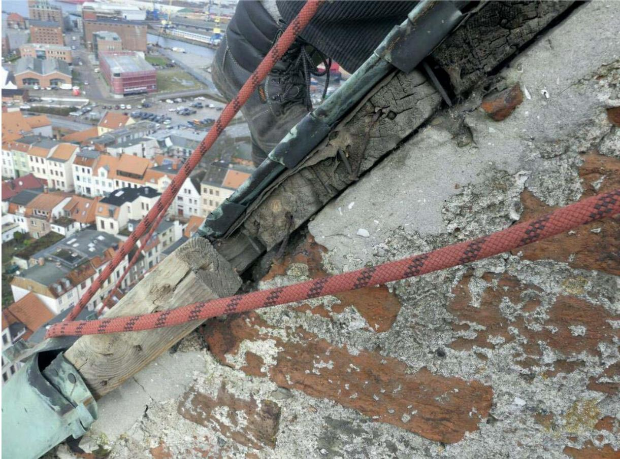
**Bild T-05:** Freiliegende Schalungshölzer infolge fehlendem Ortgangblech und Leiste.
