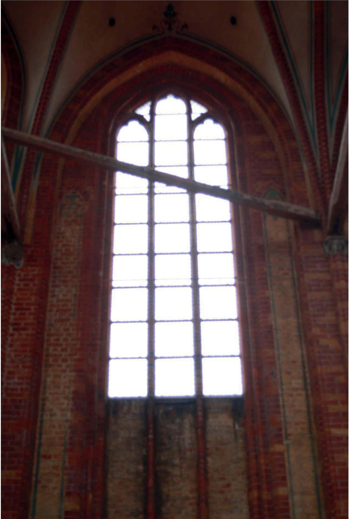
**Bild G-07:** M8: Südwand mit Obergadenfenster, Schwitzwasserrinne reparaturbedürftig, Verschmutzungen und Versalzungen der Wandfassung.
