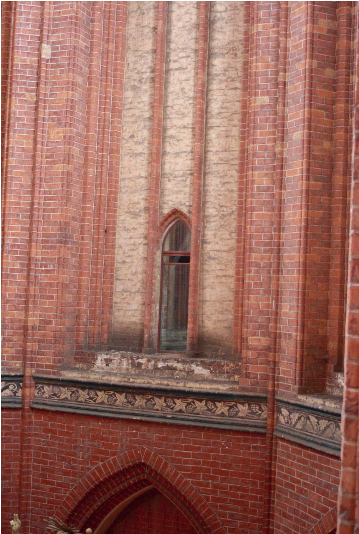
**Bild G-12:** M8: Ostwand mit verglaster Sangerluke, Verschmutzung der Wandfassungen, Ablosung Putz unterhalb Schwitzwasserrinne
