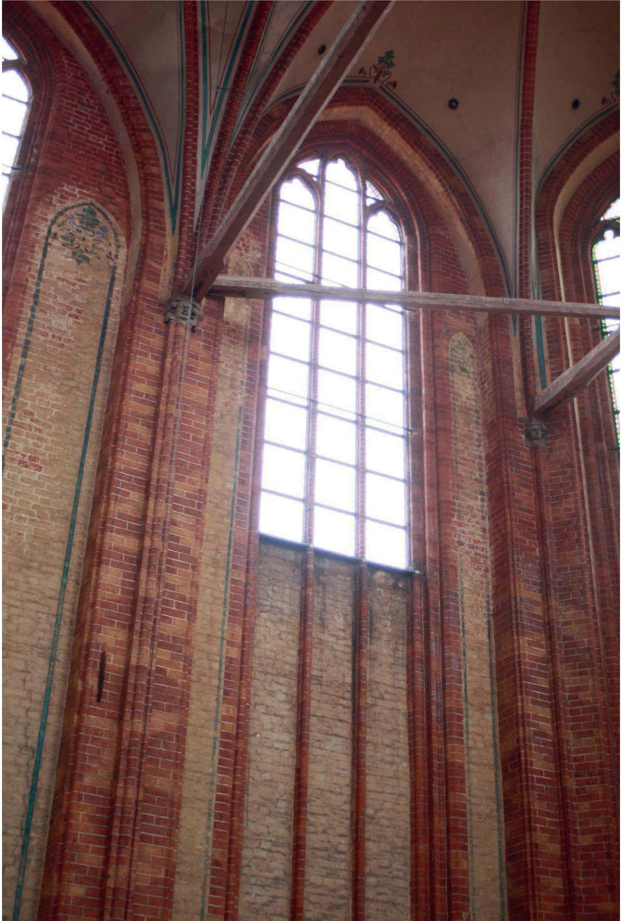
**Bild G-15:** M8: Nordwand mit Obergadenfenster, Verschmutzung der Wandfassungen, Ablösung Putz unterhalb Schwitzwasserrinne östlich Fenster, Windeisenvermörtelung locker.
