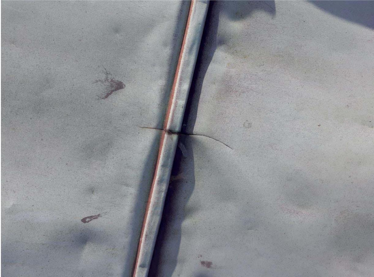
**Bild T-16:** Dachhaut im Falzbereich gerissen. Großflächige Muldenbildung infolge fehlender Befestigung.
