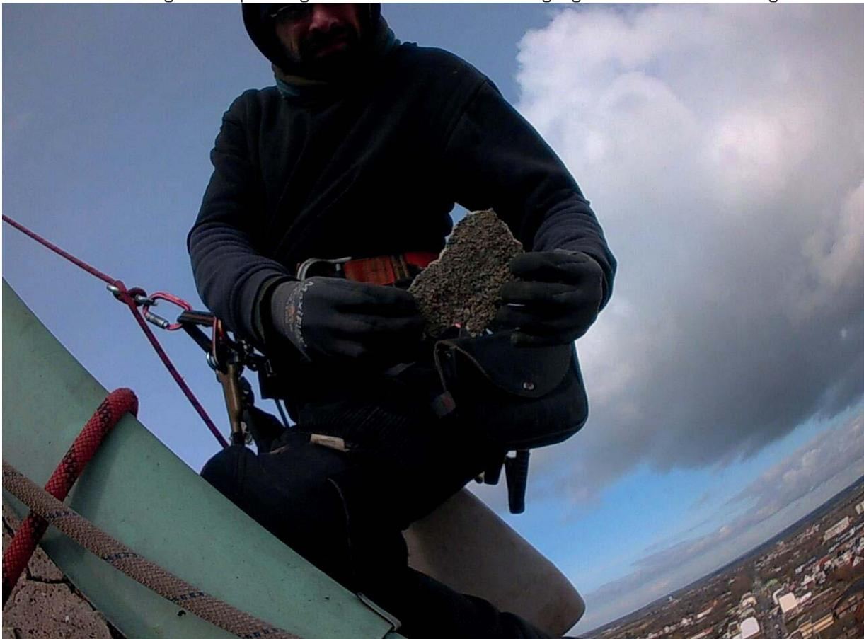
Bild T-08: Abnehmen größerer, loser Putzschollen am Ortgang.
