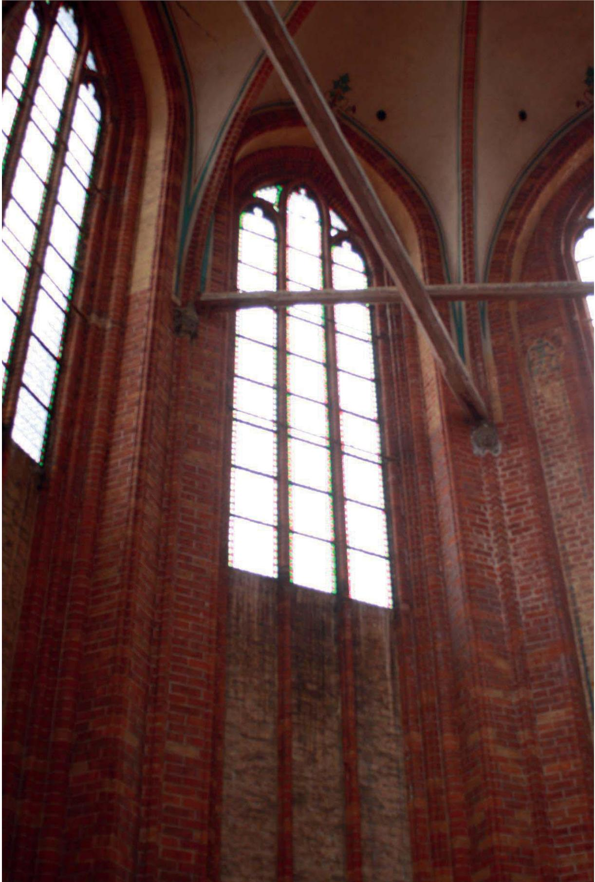
**Bild G-9:** M8: Südostwand mit Obergadenfenster, Verschmutzung der Wandfassungen, Ablösung Putz unter Schwitzwasserrinne und im Bereich östlich des Fensters, Risse Scheitel Maßwerkansatz.
