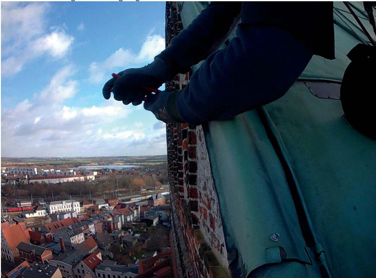
**Bild T-14:** Bröckelnder Putz und poröse Ziegel am Giebel. Ortsgangblech desolat.
