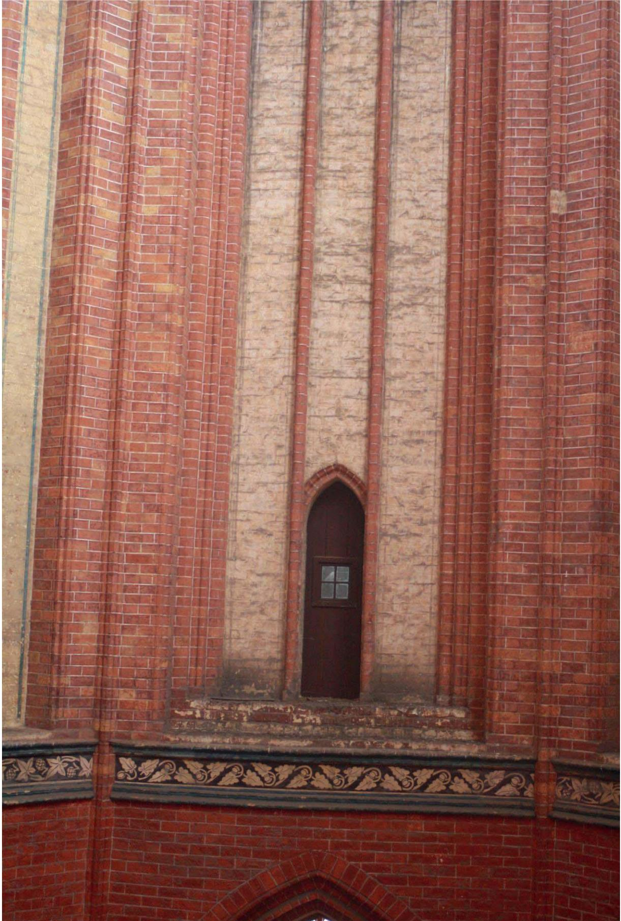
**Bild G-14:** M8: Nordostwand mit Sängerluke, Verschmutzung der Wandfassungen, Ablösung Putz unterhalb Schwitzwasserrinne, Schwitzwasserrinne reparaturbedürftig.
