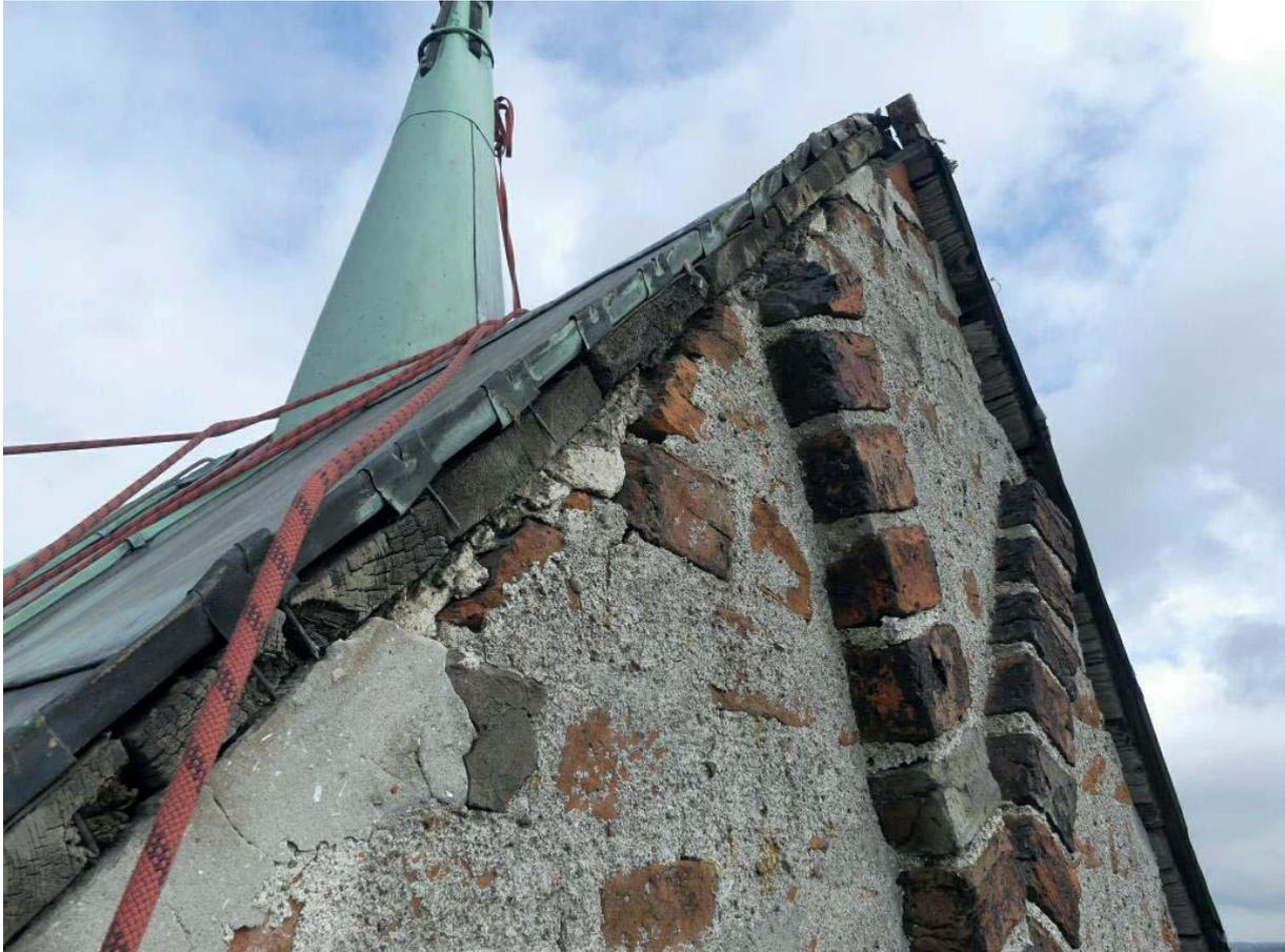
Bild T-03: Loses Mauerwerk und lockere Putzschollen am Ortgang.
