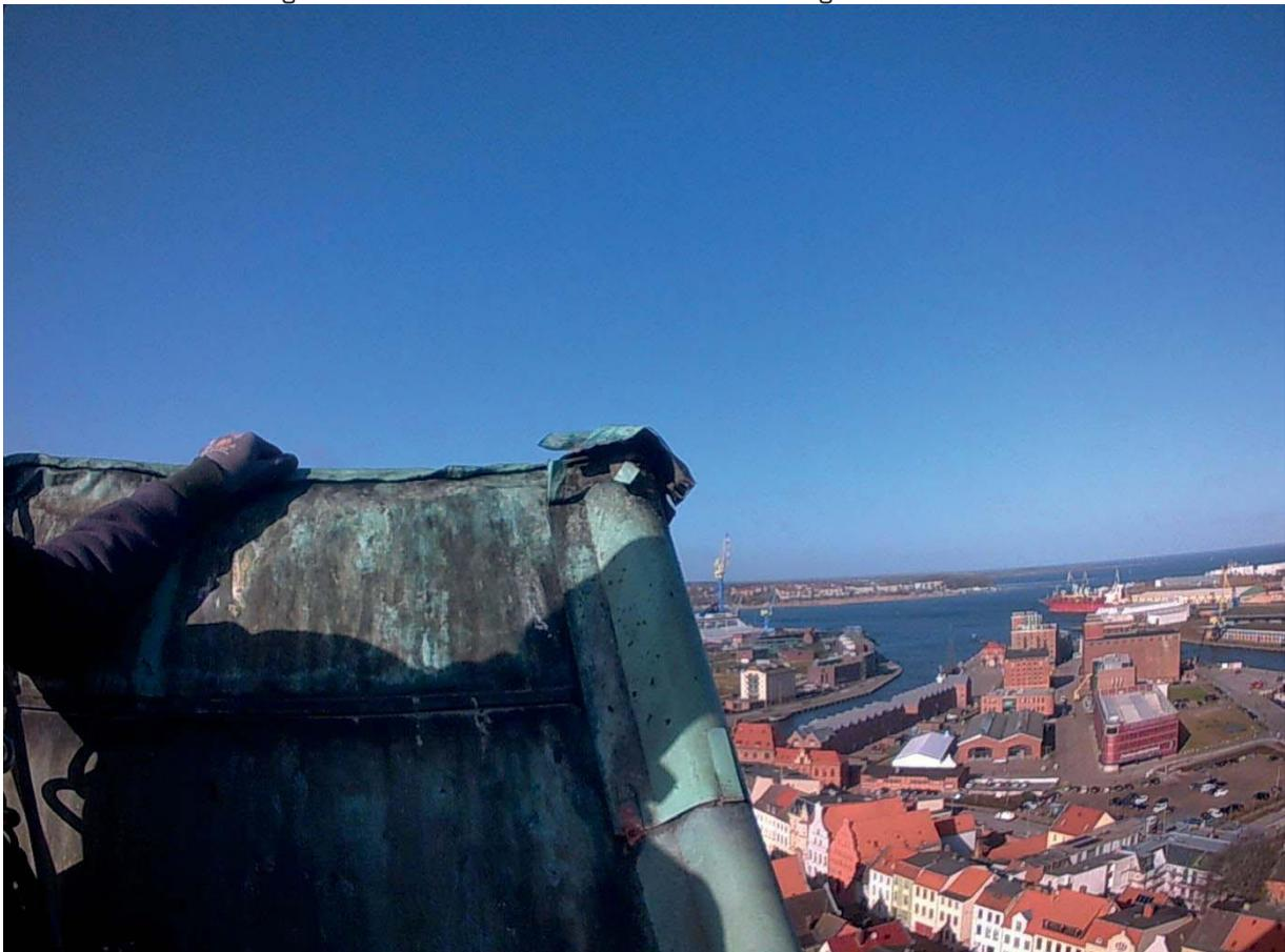
Bild T-10: Verformungen, Aufbiegungen, Ablösungen des Kupferblechs.
