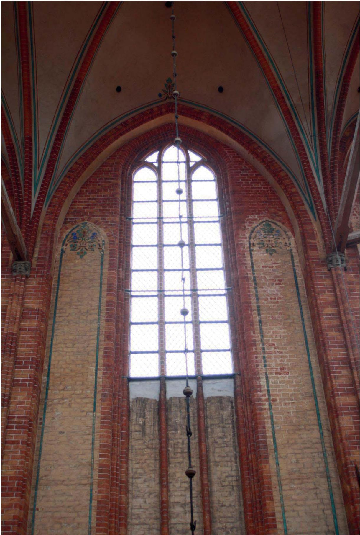
**Bild G-03:** M7: Nordwand mit Fenster im Obergaden mit Verschmutzung der Wandfassungen und Putzablösung unterhalb der Schwitzwasserrinne.
