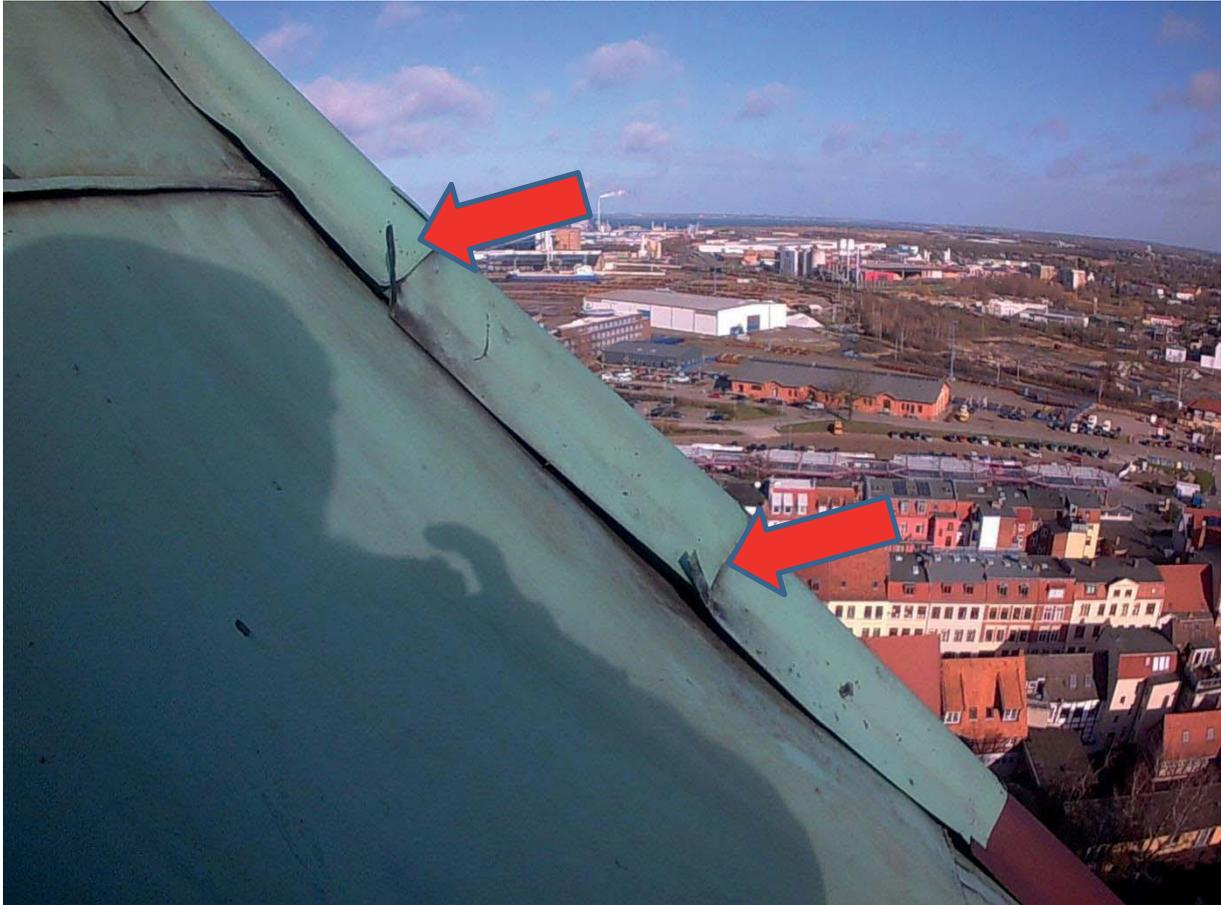
**Bild T-13:** Verbindungsblechen aufgebogen, dadurch Auftreiben der Bleche.
