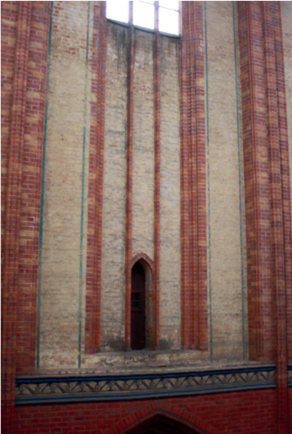
Bild G-06: M7: Südwand mit Fenster im Obergaden mit Verschmutzung der Wandfassungen, Ablösung Putz unterhalb Schwitzwasserrinne und im Bereich östlich des Fensters.
