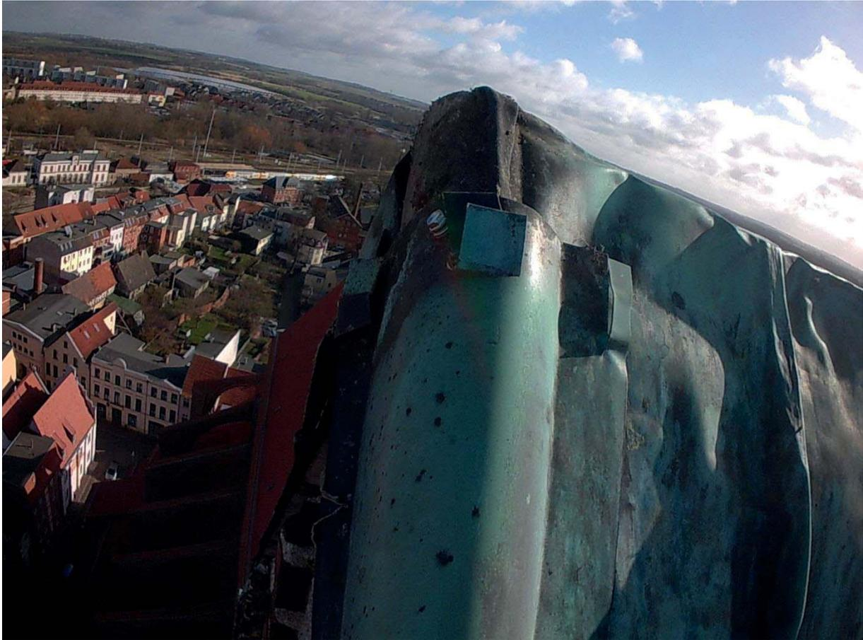
Bild T-11: Völlig deformiertes Blech am First. Falz aufgebogen. Firstkantenblech Ortgang fehlt.
