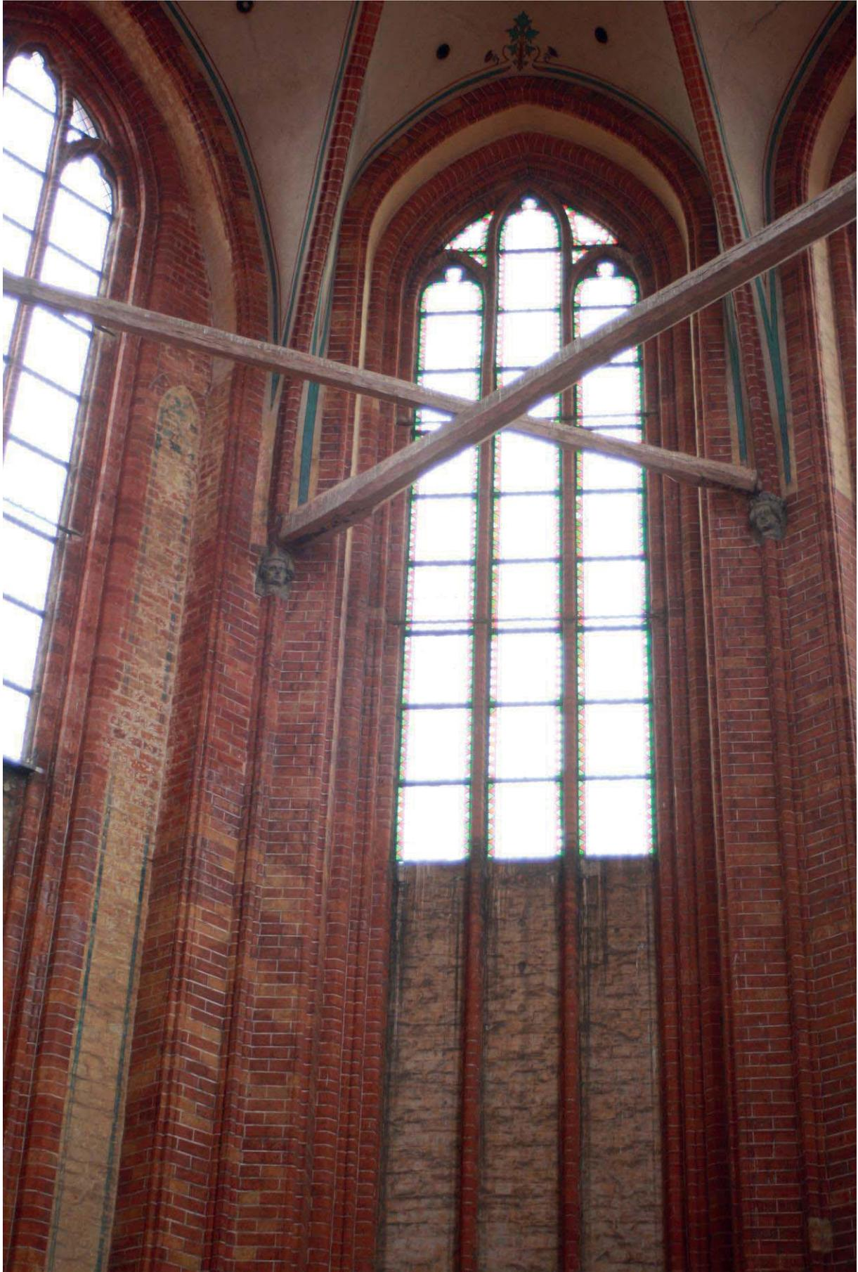
**Bild G-13:** M8: Nordostwand mit Obergadenfenster, Verschmutzung der Wandfassungen, Ablösung Putz unterhalb Schwitzwasserrinne und östlich Fenster, Schwitzwasserrinne reparaturbedürftig.
