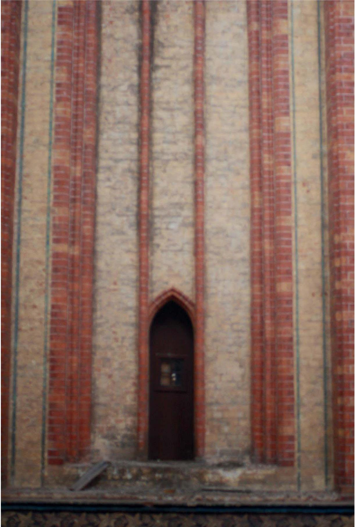
Bild G-08: M8: Südwand mit Sängerluke, Verschmutzungen und Versalzungen.
