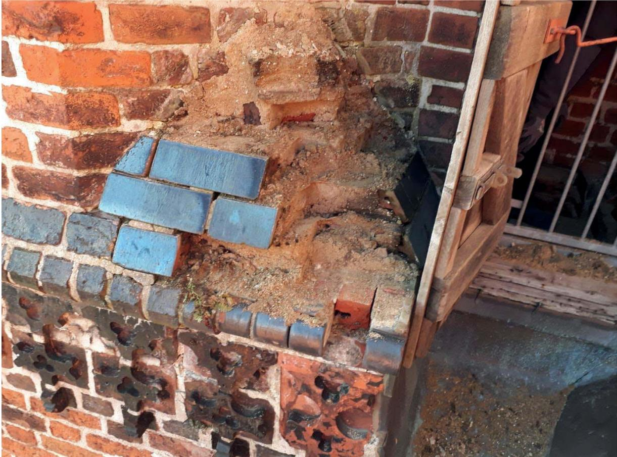
Bild T-20: Zustand Mauerwerks-Ziertürmchen vor dem Entfernen.
