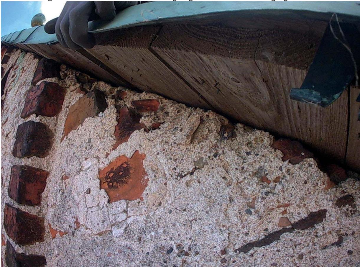
Bild T-12: Bröckelnder Putz am Giebel. Ortgangblech desolat.
