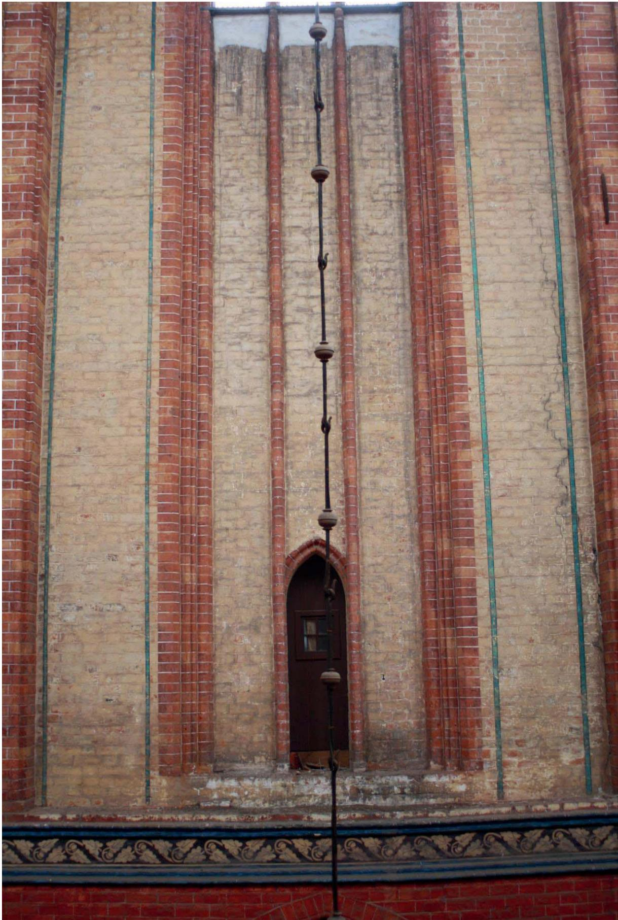
**Bild G-04:** M7: Nordwand mit Fenster im Obergaden mit Verschmutzung der Wandfassungen, Ablösung Putz unterhalb Schwitzwasserrinne und Risse ab Höhe Eisenanker im Arkadenbogenmauerwerk.
