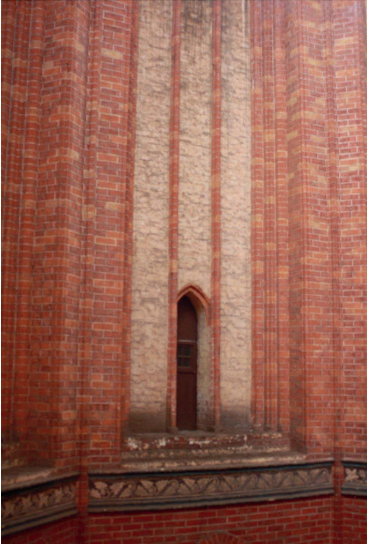
**Bild G-10:** M8: Südostwand mit Sängerluke, Verschmutzung der Wandfassungen, Ablösung Putz unterhalb Schwitzwasserrinne.
