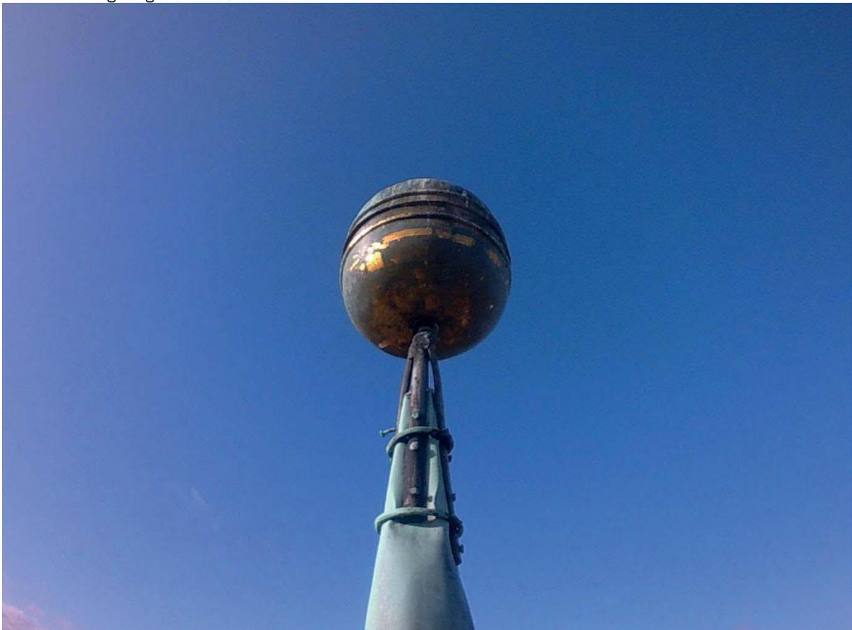
**Bild T-19:** Deformiertes Dach-Ziertürmchen.
