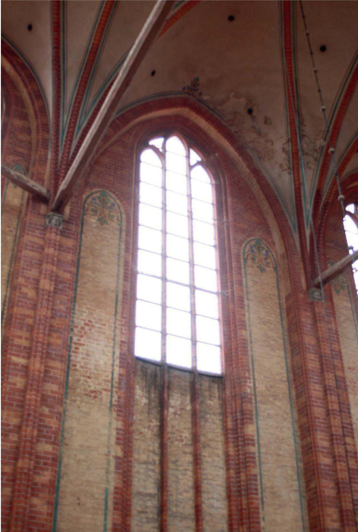
**Bild G-05:** M7: Südwand mit Fenster im Obergraden, Verschmutzung der Wandfassungen, Ablösung Putz unterhalb Schwitzwasserrinne und im Bereich östlich des Fensters, Versalzung und Putzablösungen im westlichen Gewölbezwickel, Riss in der westlichen Laibung bis ins Maßwerk.
