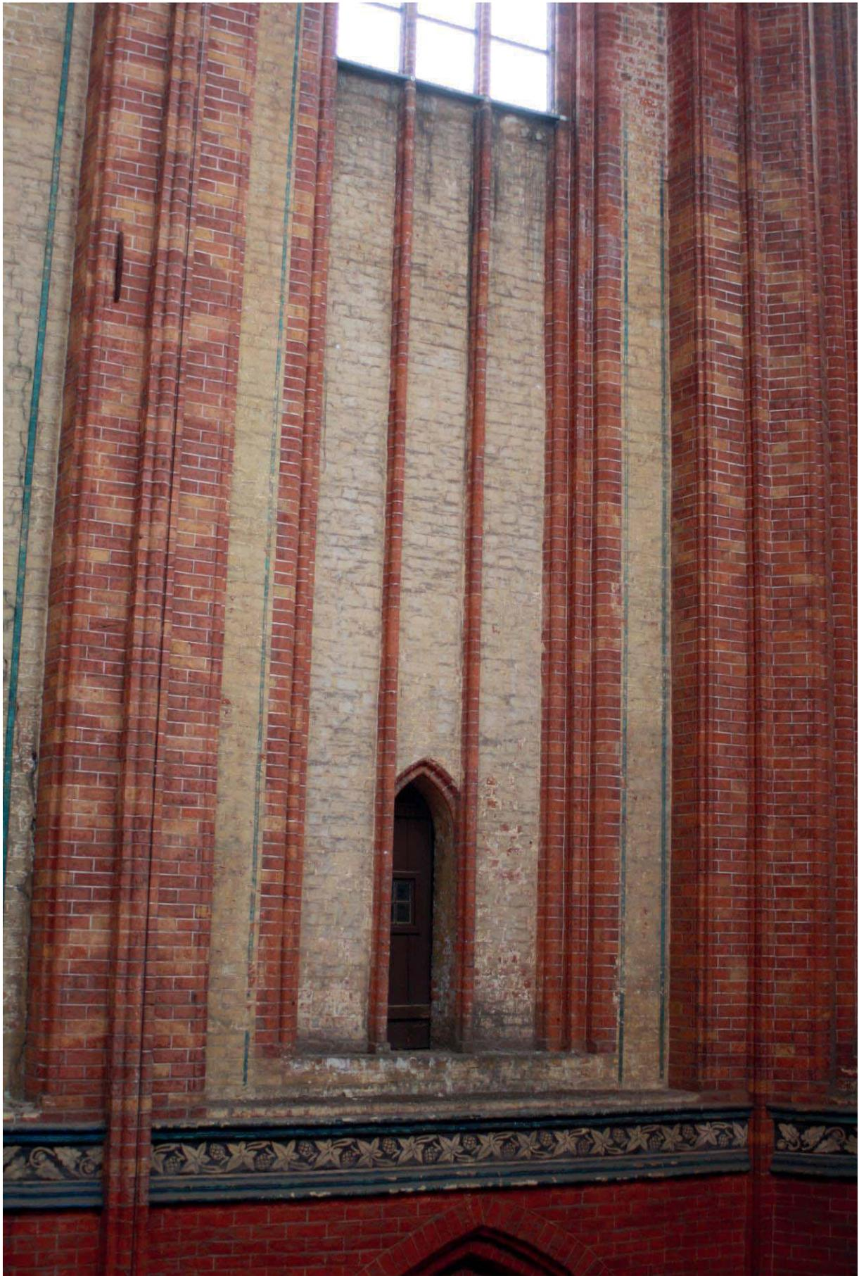
**Bild G-16:** M8: Nordwand mit Sängerluke, Verschmutzung der Wandfassungen, Ablösung Putz unterhalb Schwitzwasserrinne.
